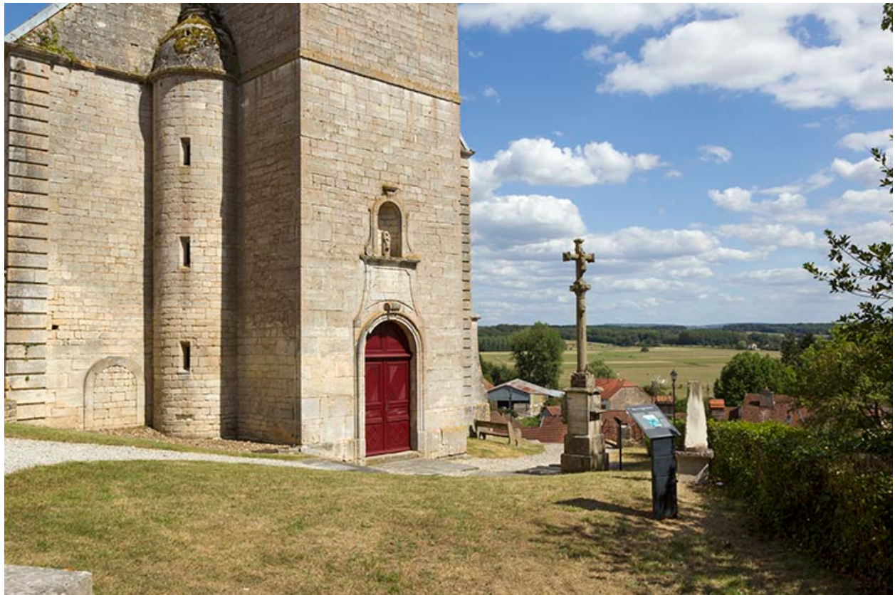
Vue du rez-de-chaussée de la tour-clocher.
