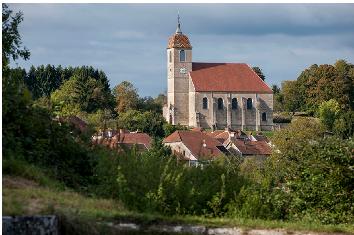
Vue générale depuis la Saône.
