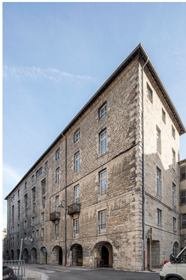
Elévation sur rue depuis le sud-ouest. Phot. Nicolas Waltefaugle IVR43_20253900168NUC4A
