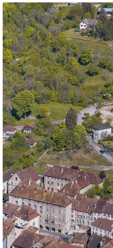
Vue plongeante, depuis l'ouest. Phot. Thierry Kuntz IVR43_20223900607NUC4A
