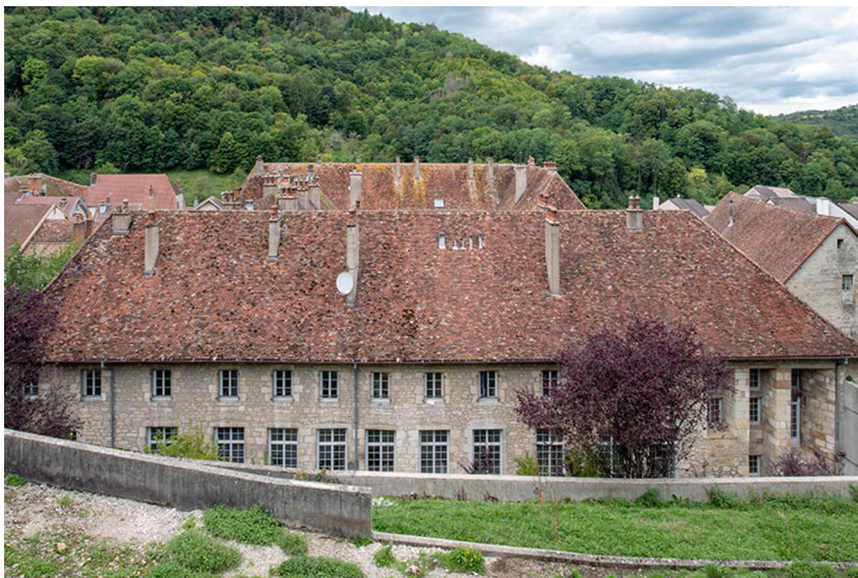
Bâtiment amont. Façade est.
