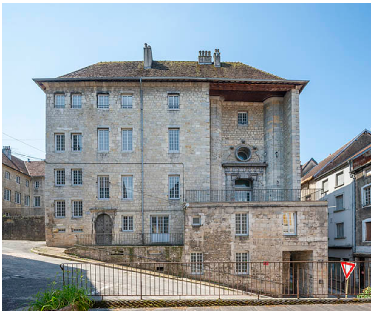
Façade nord du bâtiment sur rue.
