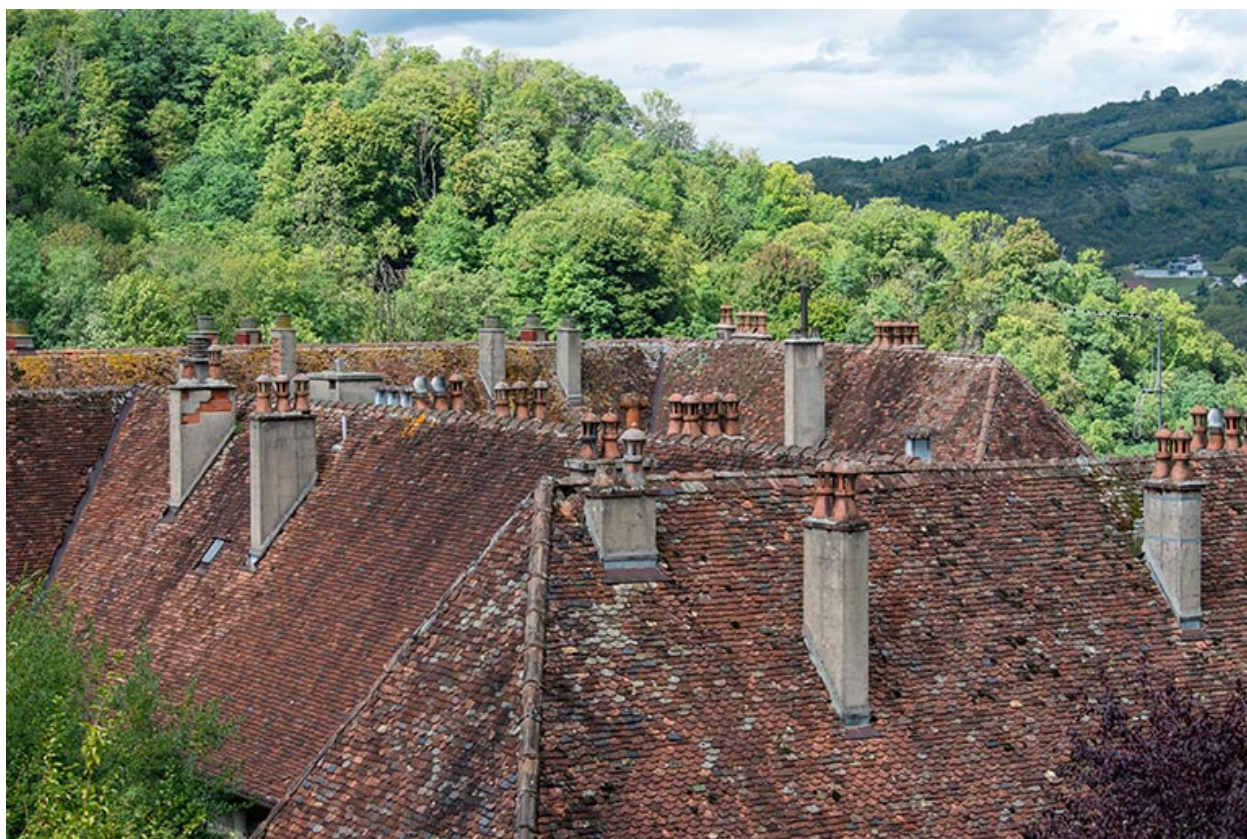
Vue rapprochée sur les toits.
