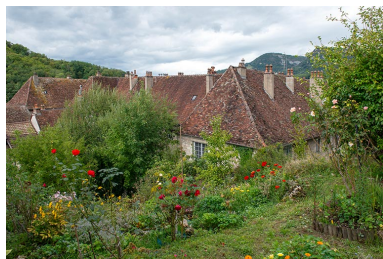
Toitures du couvent, depuis le sud-est. Phot. Nicolas Waltefaugle IVR43_20253900226NUC4A
