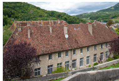
Façade est du bâtiment amont. Phot. Nicolas Waltefaugle IVR43_20253900227NUC4A
