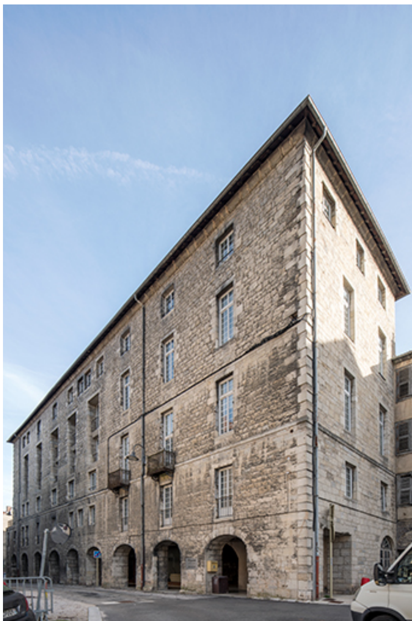
Elévation sur rue depuis le sud-ouest.
