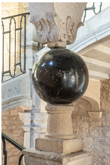
Premier étage de l'escalier dit "aux boules de pierre". Détail de la retombée d'un arc sur la sphère noire. Phot. Jérôme Mongreville IVR43_20243900755NUC4A
