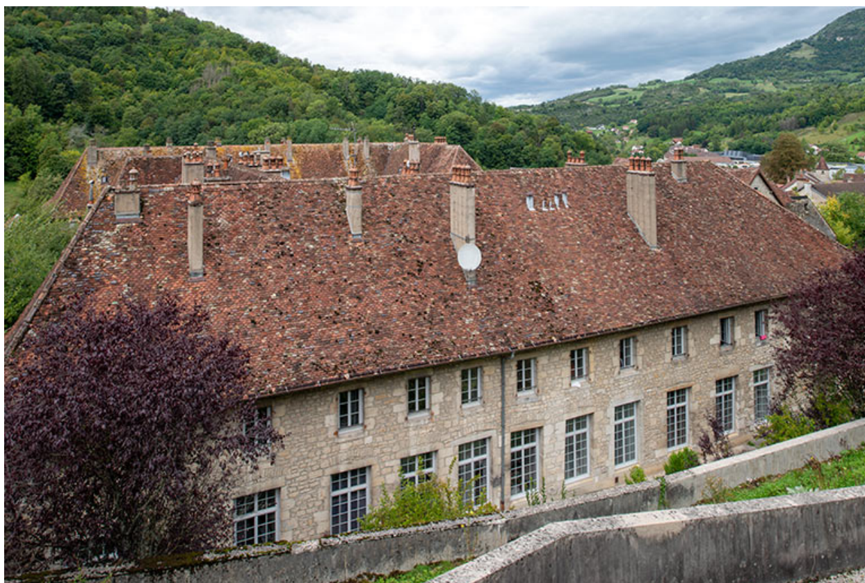
Façade est du bâtiment amont.
