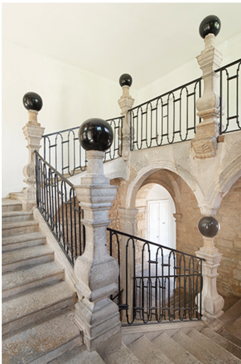
Escalier dit "aux boules de pierre". Rampe en ferronnerie et balustres entre le premier et le second étage.
