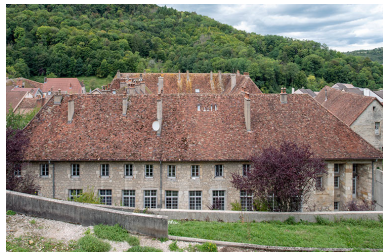
Bâtiment amont. Façade est. Phot. Nicolas Waltefaugle IVR43_20253900229NUC4A
