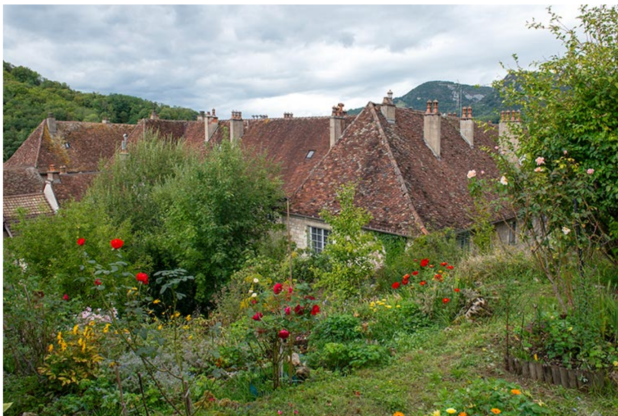
Toitures du couvent, depuis le sud-est.
