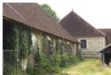
Contreforts du mur nord de la halle à charbon. Phot. Jérôme Mongreville IVR43_20087000929NUC2A
