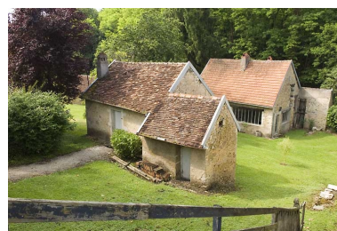
Logement ouvrier et dépendances. Phot. Jérôme Mongreville IVR43_20087000921NUC2A
