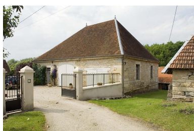
Le haut fourneau vu depuis le sud-est. Phot. Jérôme Mongreville IVR43_20087000927NUC2A
