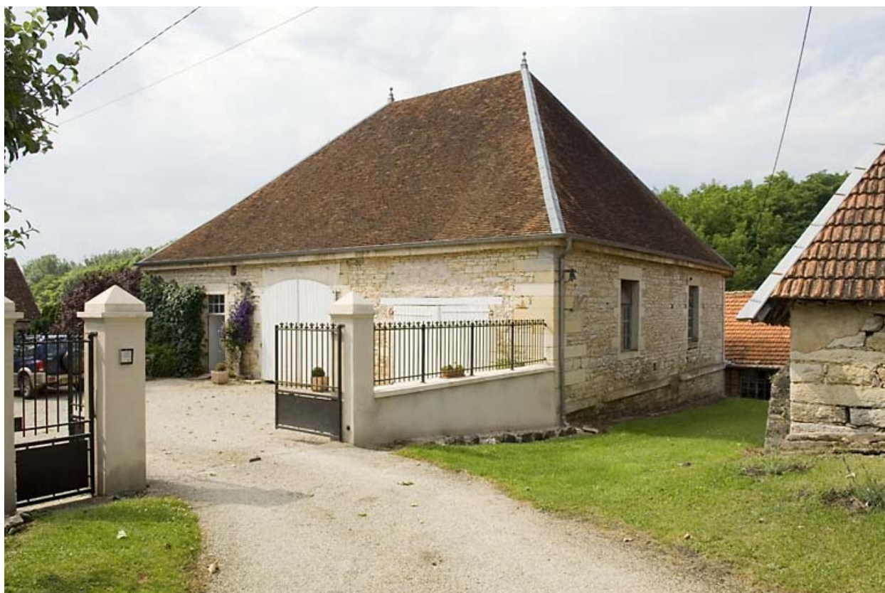
Le haut fourneau vu depuis le sud-est.
