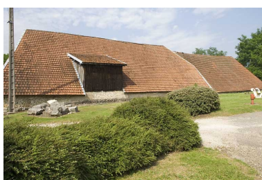
Vue d'ensemble de la halle à charbon. Phot. Jérôme Mongreville IVR43_20087000925NUC2A
