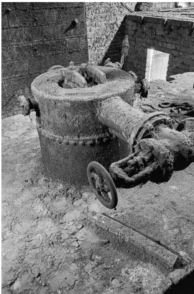
Partie supérieure de la chaudière. Vannage.
