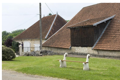
Le haut fourneau et la halle à charbon. Phot. Jérôme Mongreville IVR43_20087000930NUC2A
