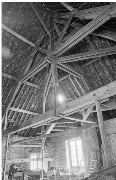
La charpente du haut fourneau en 1979.
