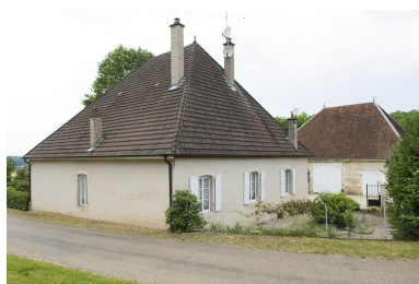
Logement patronal et haut fourneau. Phot. Jérôme Mongreville IVR43_20087000932NUC2A
