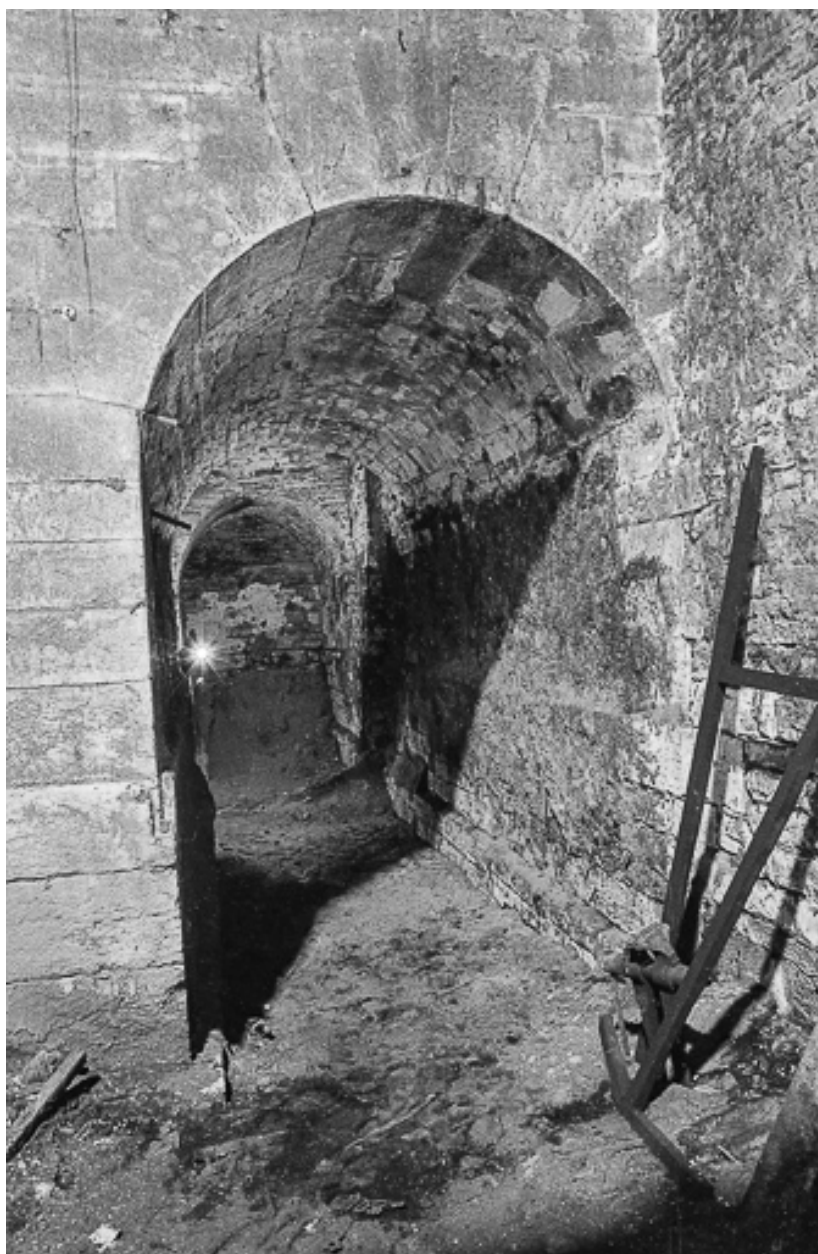
Base du haut fourneau en 1979. Galerie ouest.
