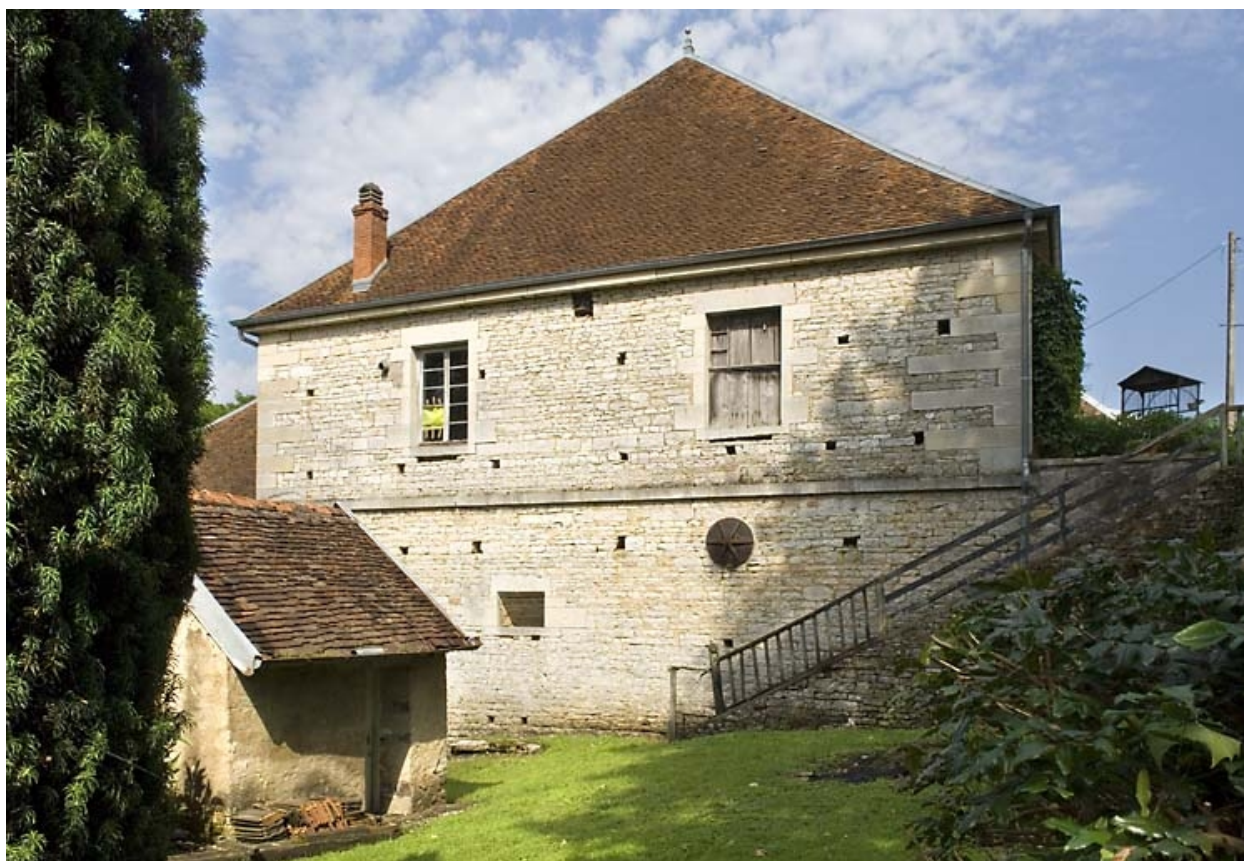
Façade ouest du haut fourneau.
