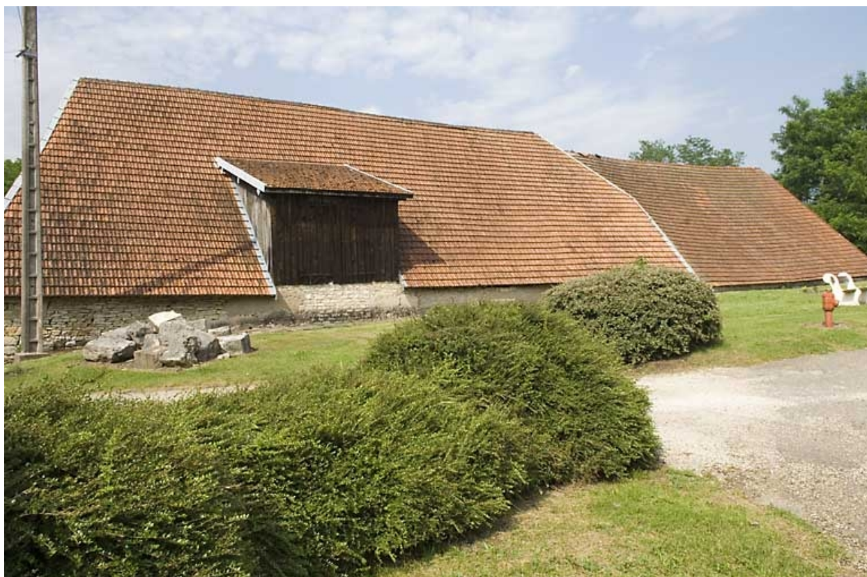
Vue d'ensemble de la halle à charbon.
