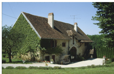
Logement ouvrier ouest. Vue de trois quarts en 1989. Phot. Jérôme Mongreville IVR43_19897000802ZA
