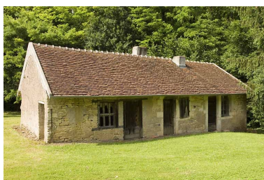
Logement ouvrier (tronqué). Phot. Jérôme Mongreville IVR43_20087000923NUC2A
