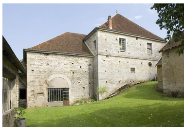
Le haut fourneau vu depuis l'ouest. Phot. Jérôme Mongreville IVR43_20087000924NUC2A
