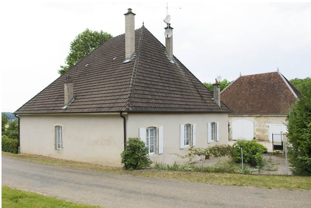
Logement patronal et haut fourneau.
