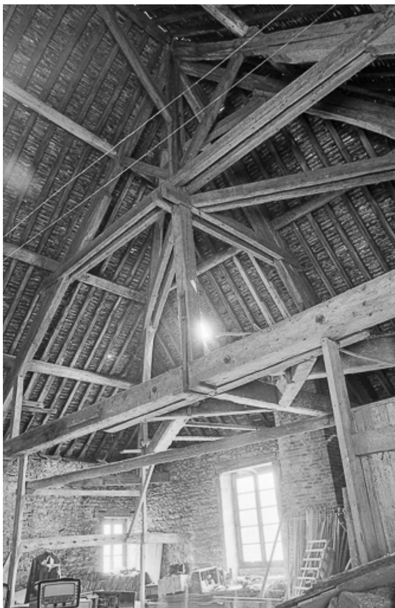
La charpente du haut fourneau en 1979.
