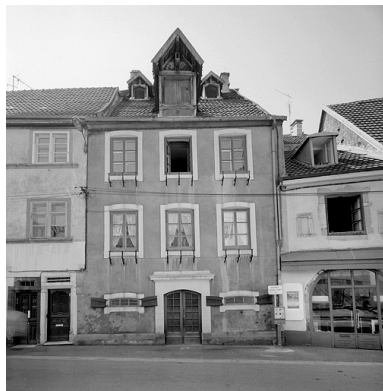
Façade sur rue. Phot. Jérôme Mongreville IVR43_19882500059V
