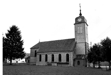
Façade latérale gauche. Phot. Yves Sancey IVR43_19752500689X
