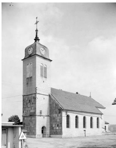
Façade latérale droite. Phot. Yves Sancey IVR43_19752500652V
