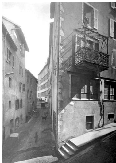
[Façades à l'angle de la rue des Etapes et de celle des Petites Etapes], [1926]. Phot. Jérôme Mongreville, Autr. Adrien Comoy IVR43_19923900141X
