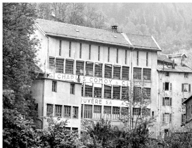
[Façades sur la rue des Etapes], [milieu 20e siècle]. Phot. Jérôme Mongreville IVR43_19923900122X
