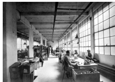
[Triage ou tubage des pipes], [1926]. Phot. Jérôme Mongreville, Autr. Adrien Comoy IVR43_19923900151X
