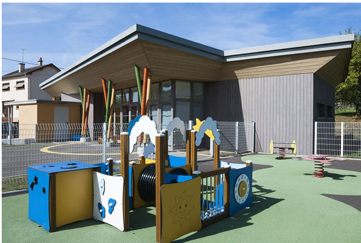
Vue générale de la crèche.
