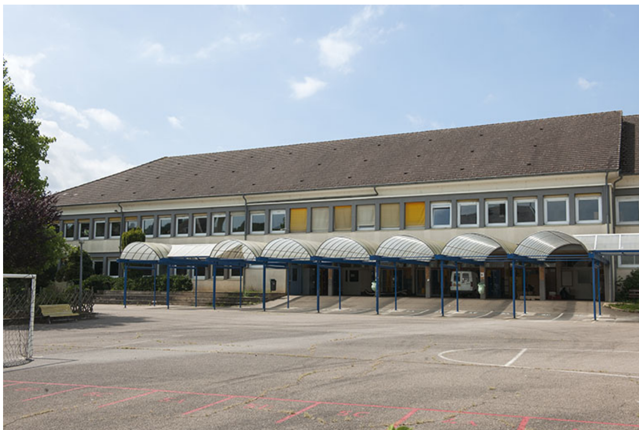
Façade du bâtiment depuis la cour.
