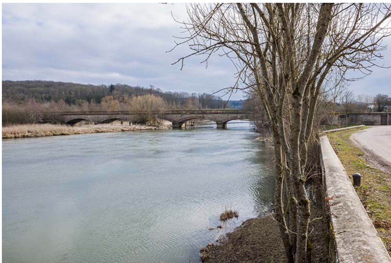
Pont ferroviaire sur la Lanterne (ligne Nancy-Gray).
