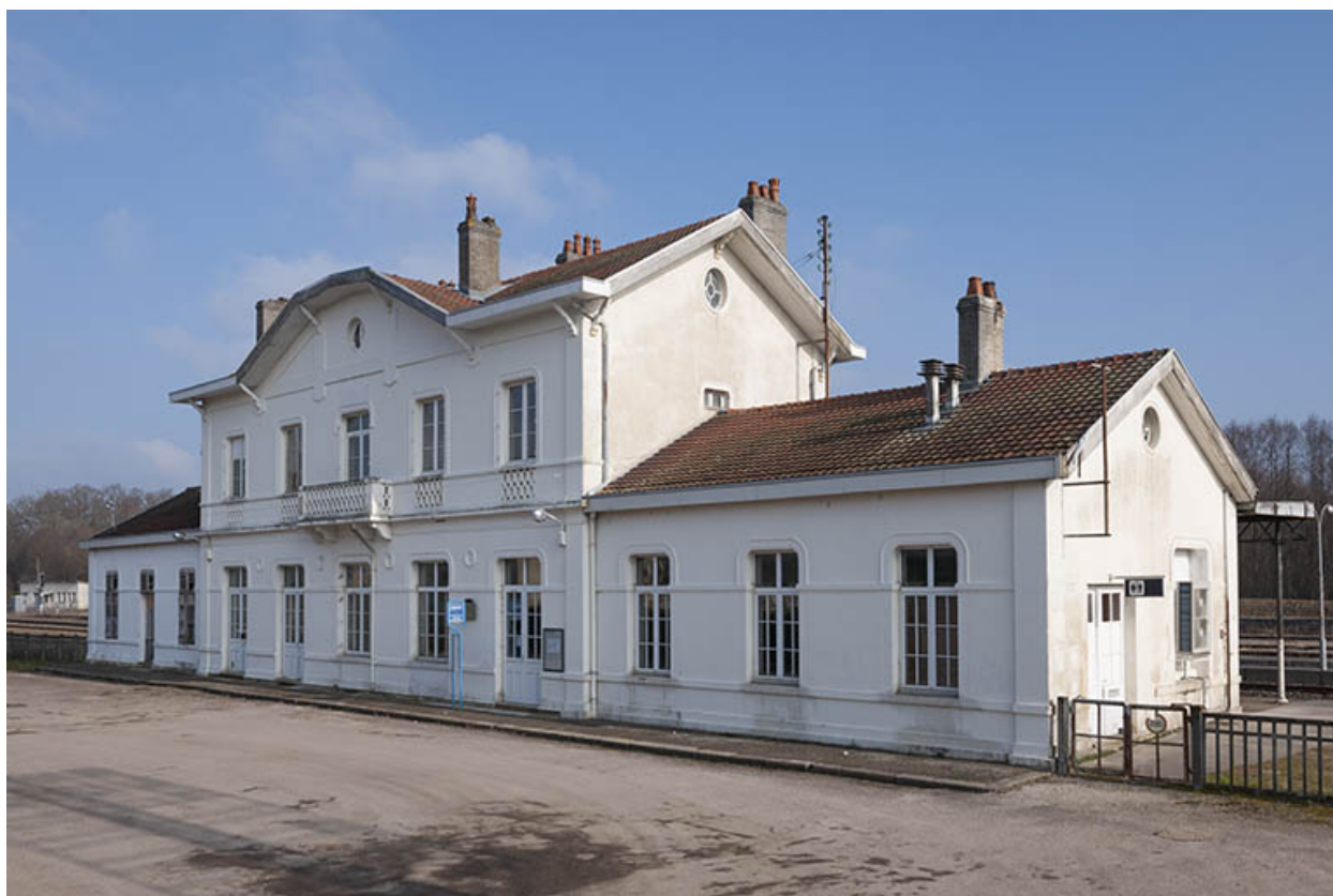
Port-d'Atelier : vue générale de la gare.
