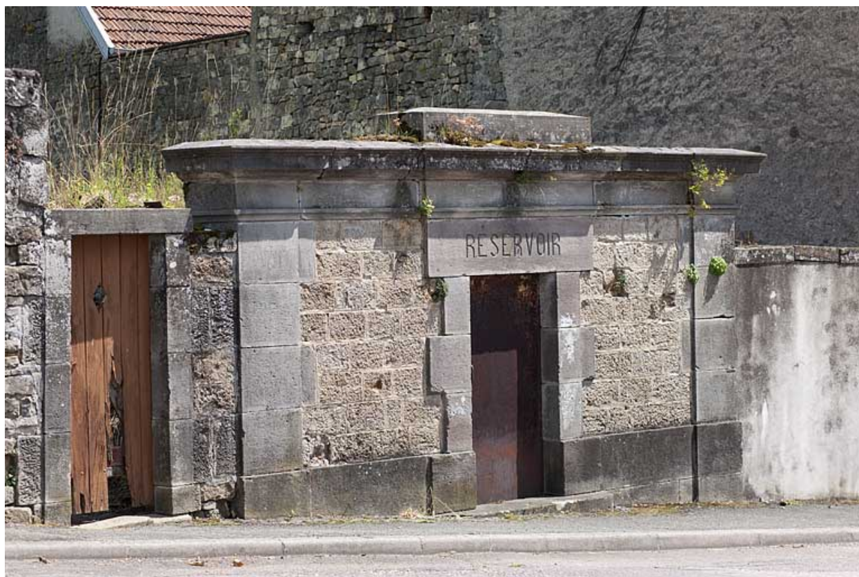
Le réservoir (AB 697), rue du Général Rébillot.
