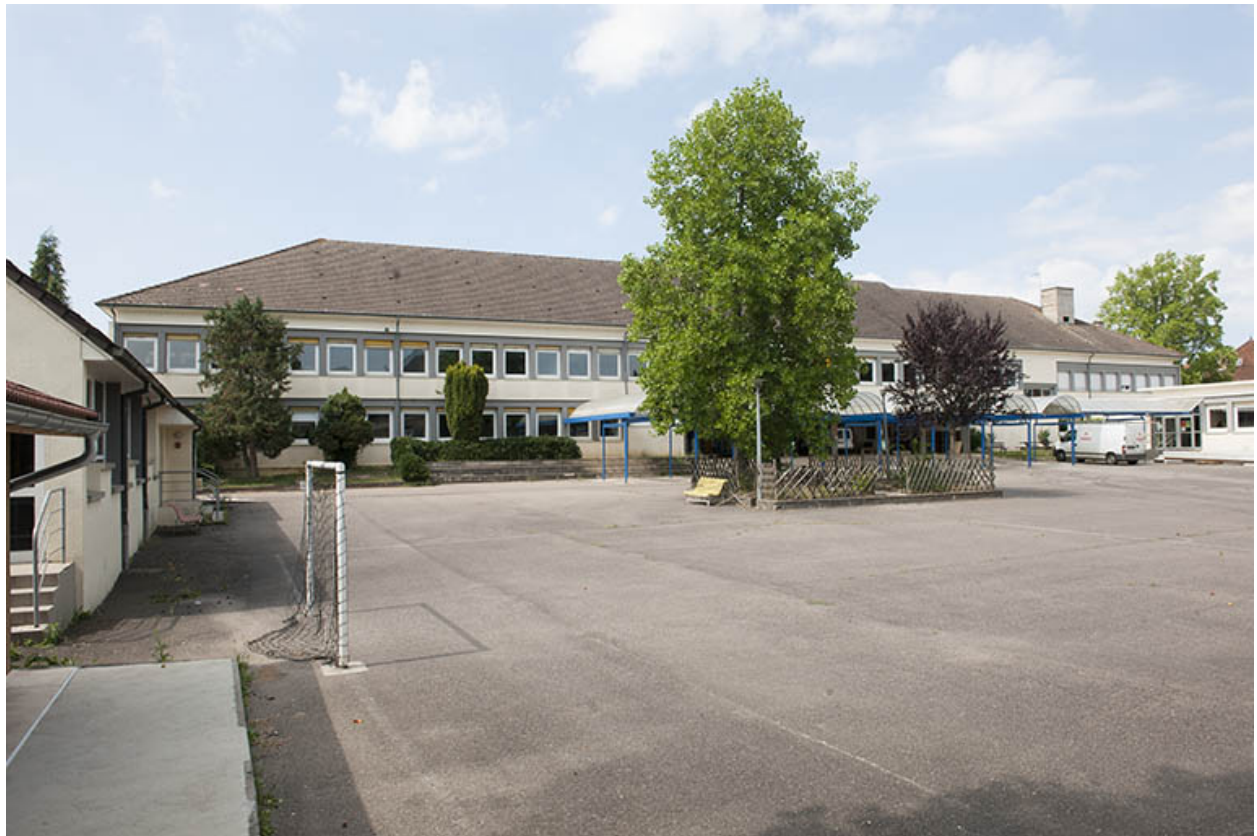
Vue générale sur la cour.
