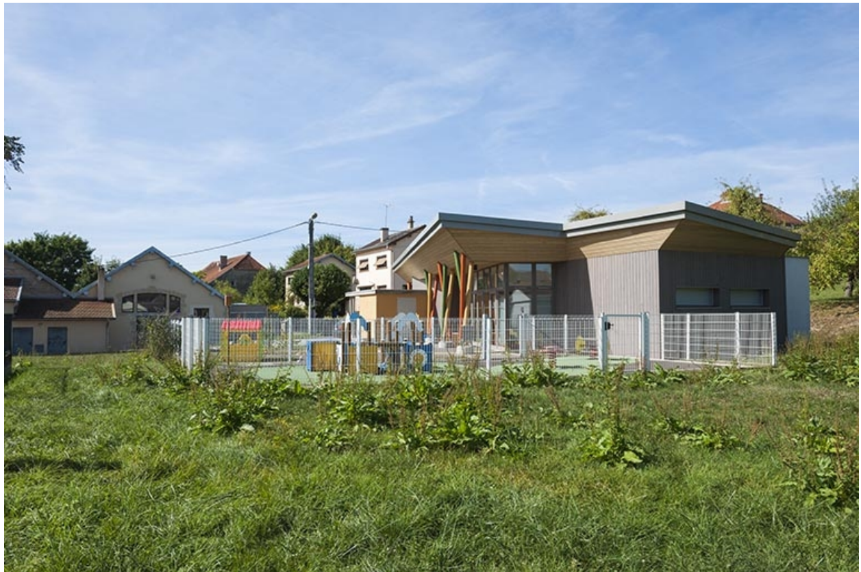
Vue d'ensemble de la crèche.
