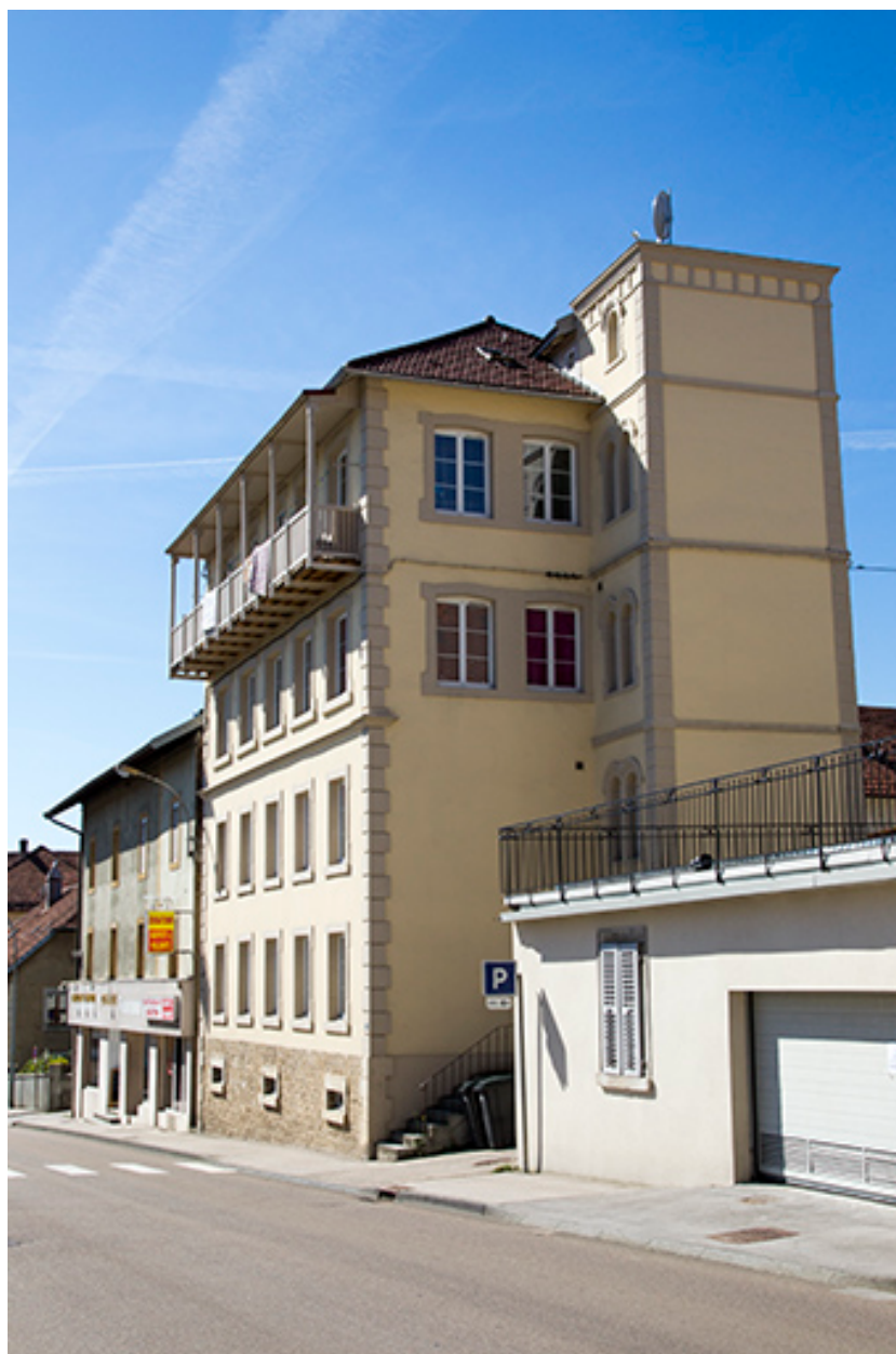
Usine : façades antérieure et latérale droite.
