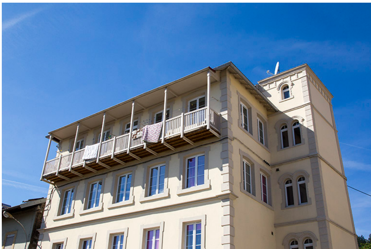
Usine, façade antérieure : étages et balcon.
