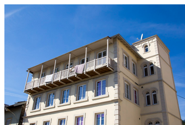
Usine, façade antérieure : étages et balcon. Phot. Yves Sancey IVR43_20132502301NUC2A
