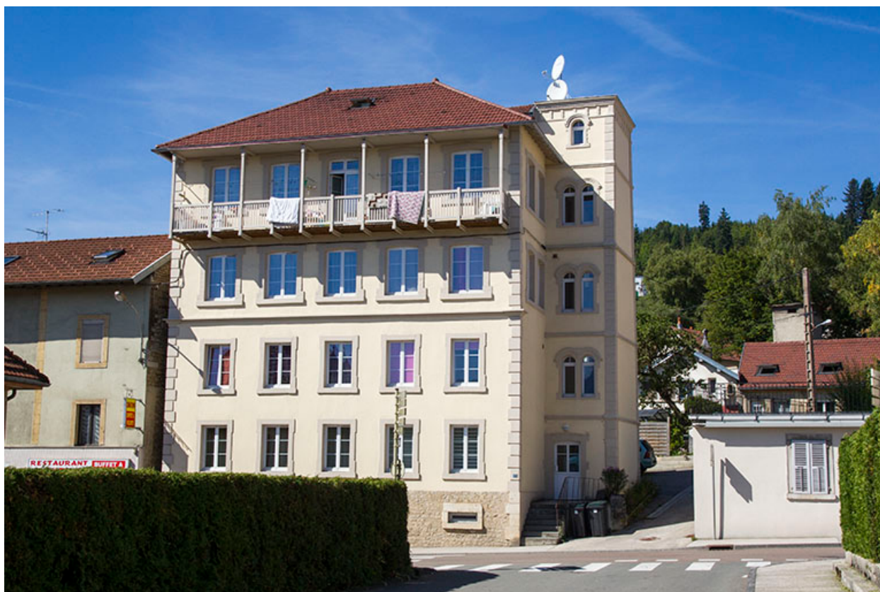
Usine : façade antérieure, de trois quarts droite.
