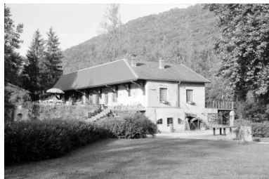
Bâtiment d'eau, vu de trois quarts droite. Phot. Laurent Poupard IVR43_19933900534Z
