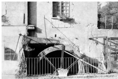
Roue en dessus et conduite d'amenée. Phot. Laurent Poupard IVR43_19933900535Z
