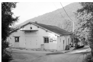
Atelier de fabrication de la Matec (A). Phot. Laurent Poupard IVR43_19933900518Z
