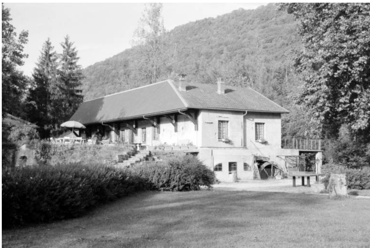
Bâtiment d'eau, vu de trois quarts droite.
