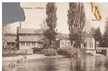
Larians (Haute-Saône). - L'Usine. Phot. Jérôme Mongreville IVR43_20097000020NUC2A
