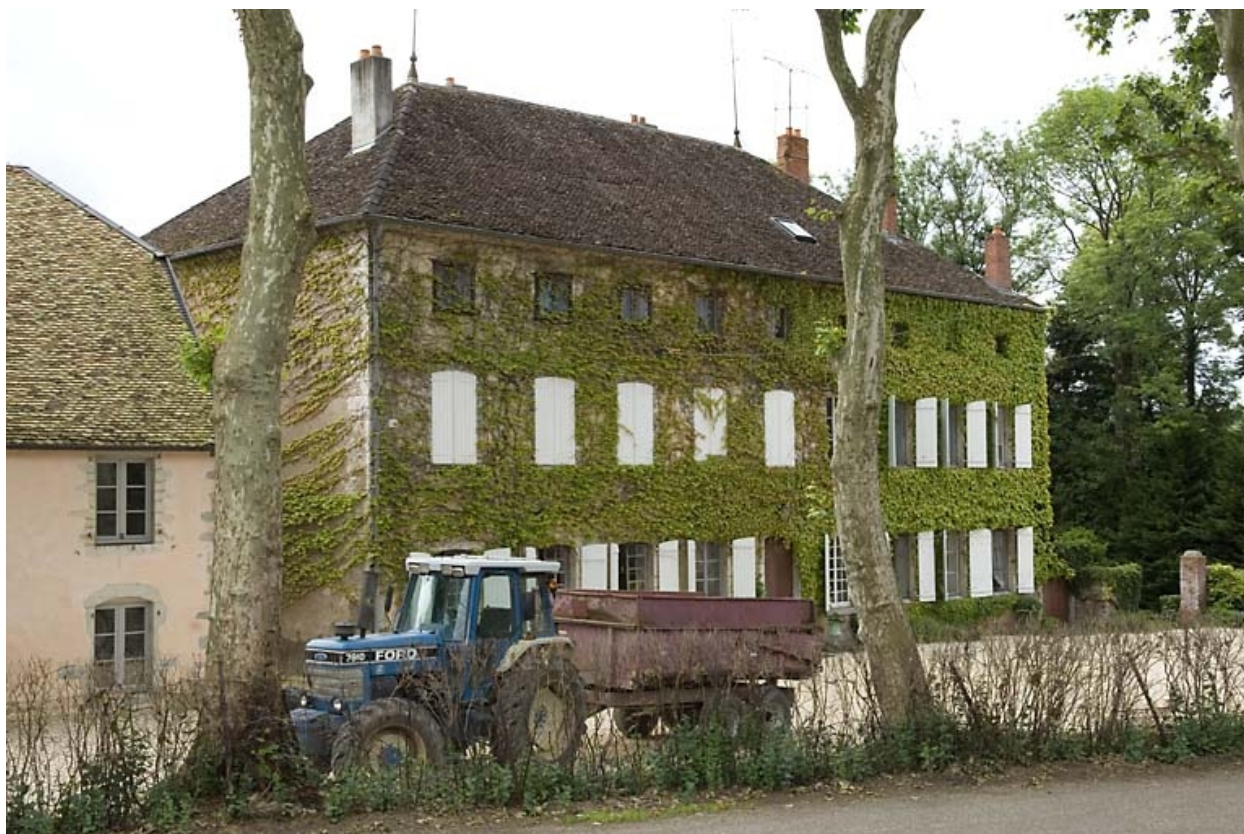
Logement patronal vu de trois quarts.
