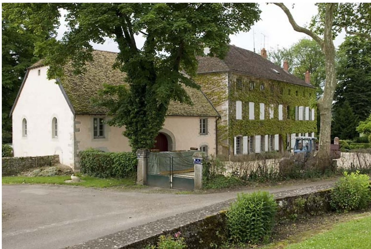
Remise, écurie et logement patronal.
