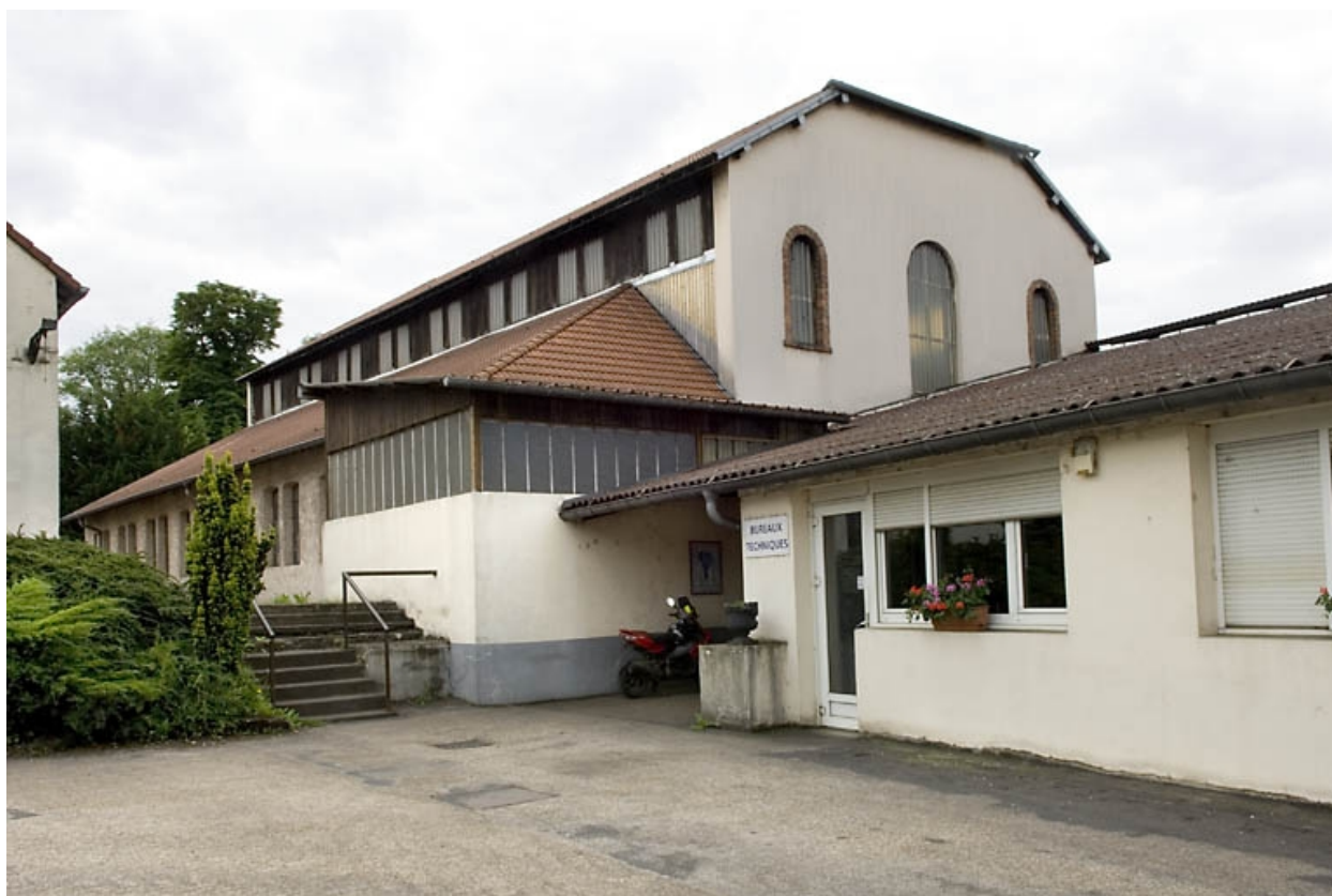
Atelier de fonderie depuis la cour.
