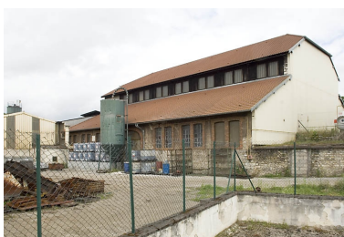
Atelier de fonderie depuis le sud-est. Phot. Jérôme Mongreville IVR43_20087000720NUC2A
