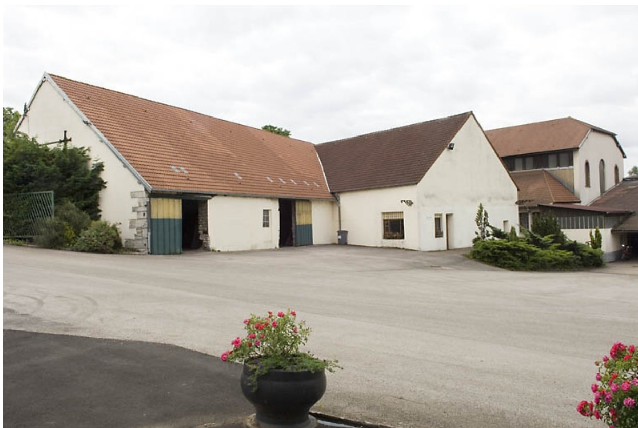
Magasin industriel et atelier de moulage.
