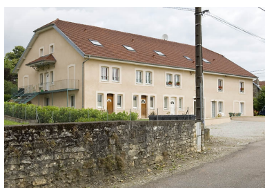
Logement ouvrier. Phot. Jérôme Mongreville IVR43_20087000721NUC2A
