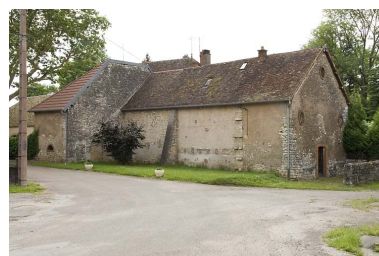
Logement du directeur. Phot. Jérôme Mongreville IVR43_20087000719NUC2A
