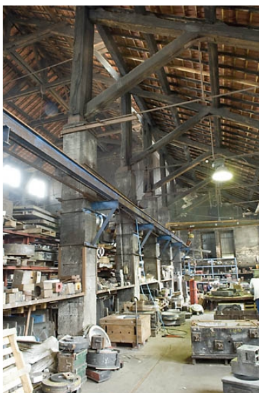
Atelier de fonderie. Le bas-côté sud. Phot. Jérôme Mongreville IVR43_20087000726NUC2A
