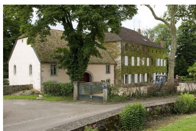
Remise, écurie et logement patronal. Phot. Jérôme Mongreville IVR43_20087000722NUC2A
