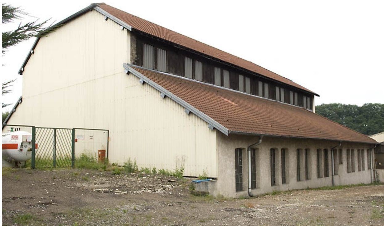
Atelier de fonderie depuis le nord-est.
