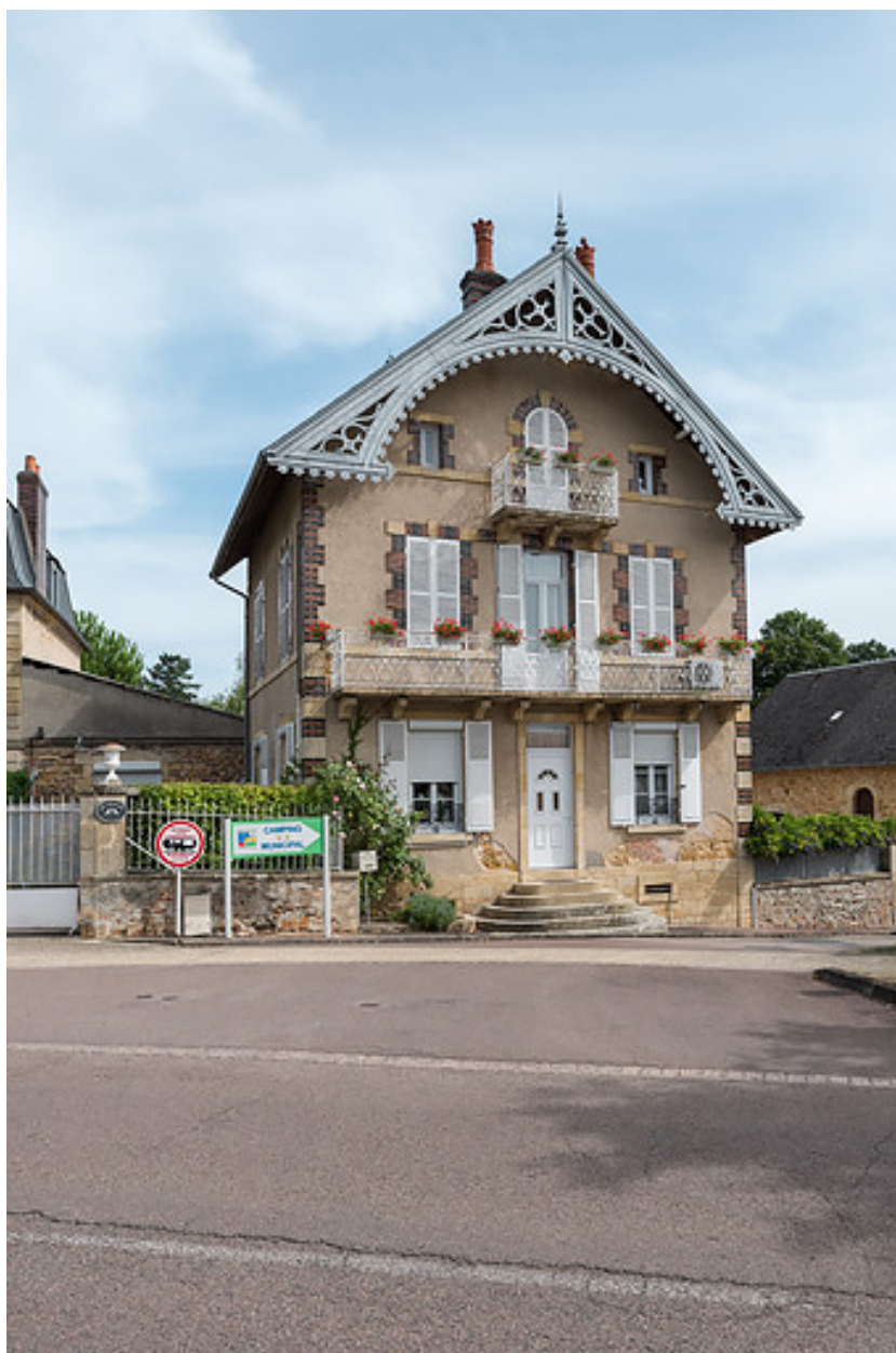
Façade principale sur l'avenue Eugène Collin.
