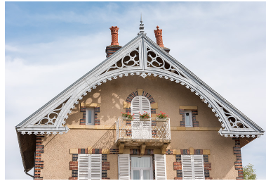
Pignon protégé par une large saillie de rive décorée d'un lambrequin métallique découpé. Phot. Pierre-Marie Barbe-Richaud IVR26_20195800694NUC4A
