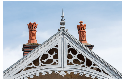
Lambrequin métallique découpé imitant un décor de menuiserie et cheminées ornées. Phot. Pierre-Marie Barbe-Richaud IVR26_20195800693NUC4A
