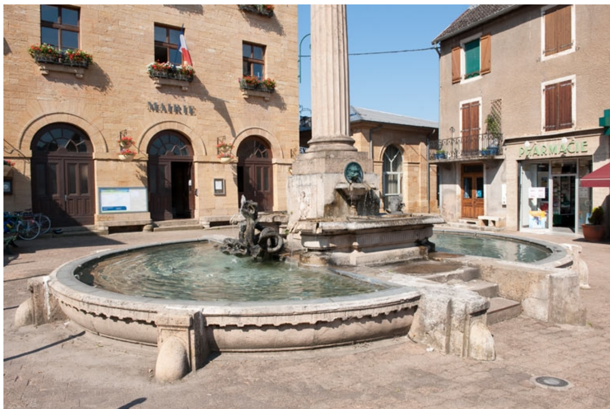
Vue générale des bassins.
