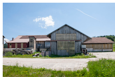
Façades ouest. Phot. Jérôme Mongreville IVR43_20162500422NUC4A
