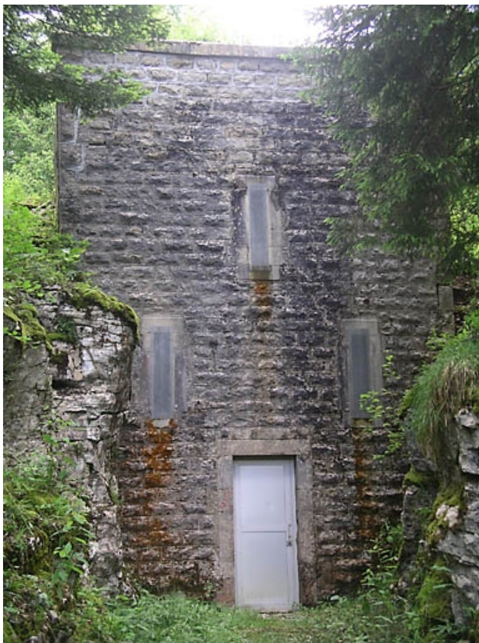
Vue générale sur construction hydraulique.
