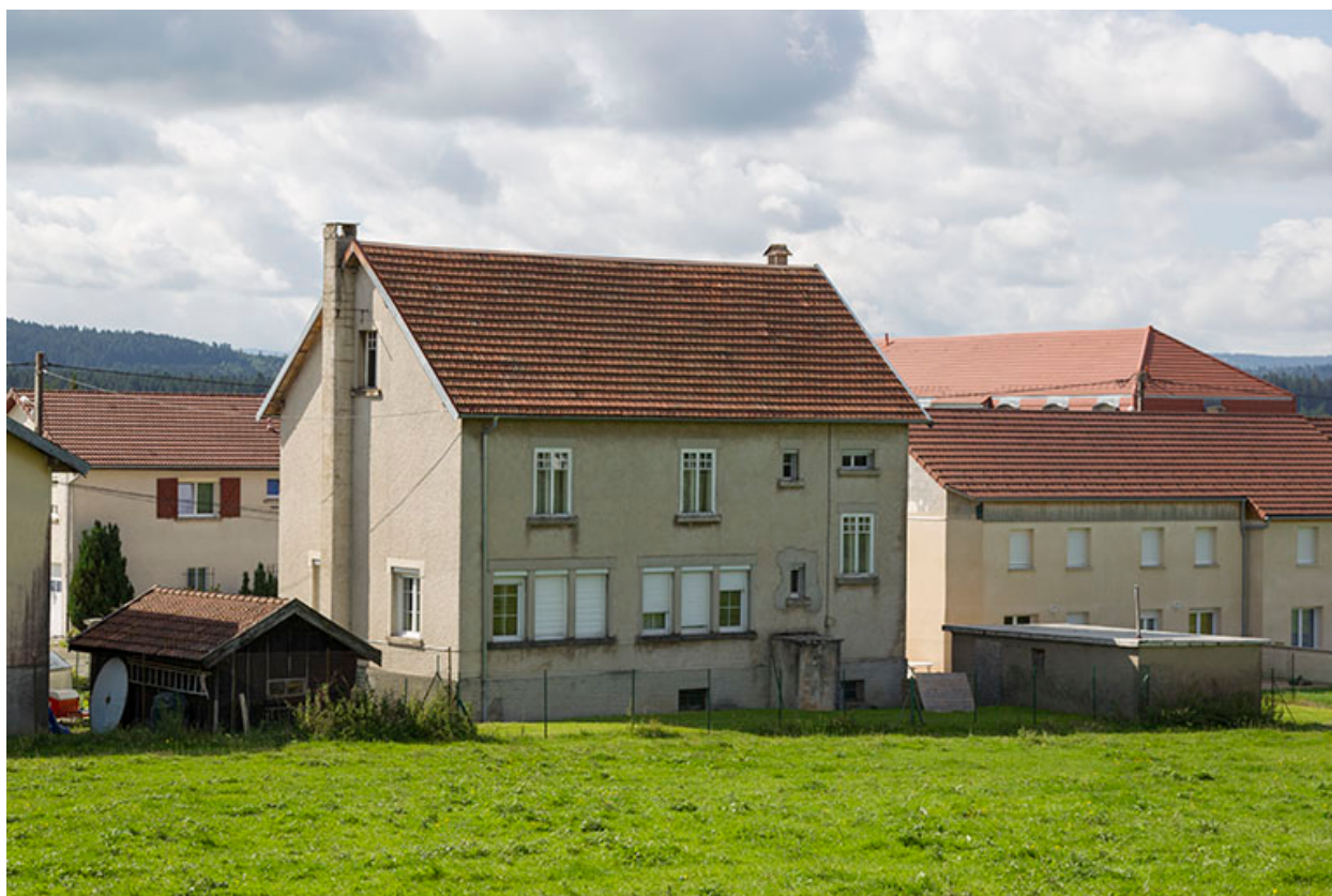
Façades postérieure et latérale droite.
