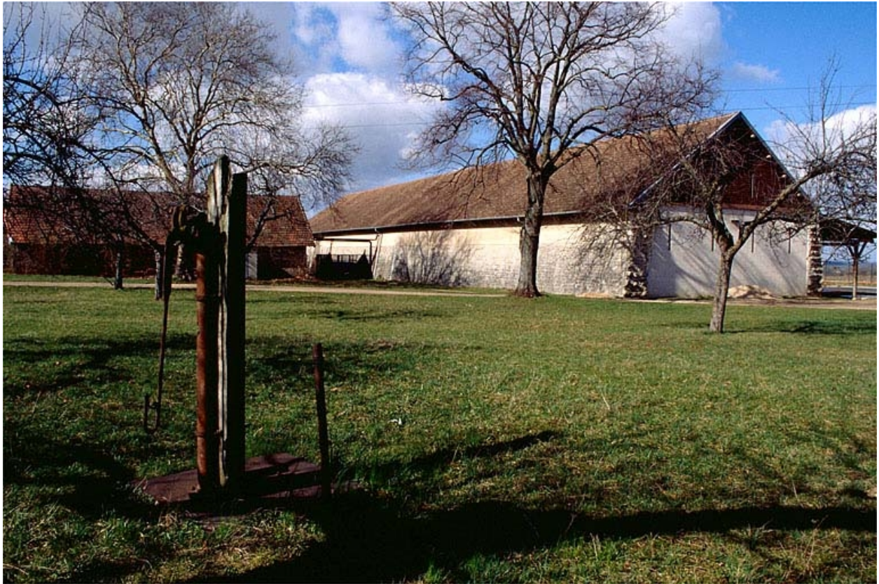
Magasin industriel vu de trois quarts arrière.
