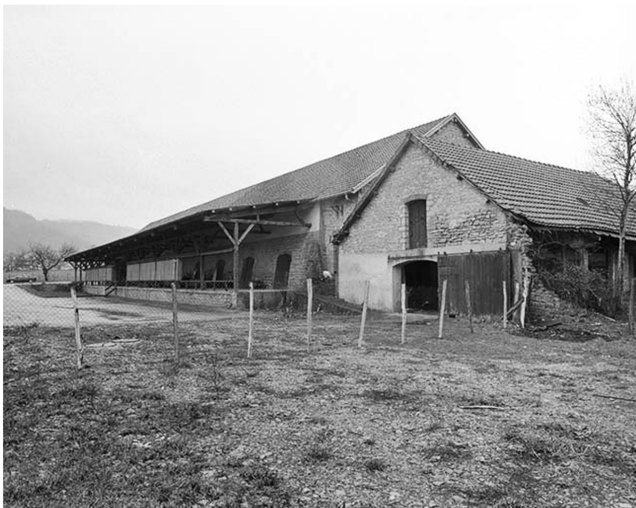
Magasin industriel et atelier de fabrication ruiné.
