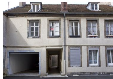
Logis secondaire, façade antérieure, de face.
