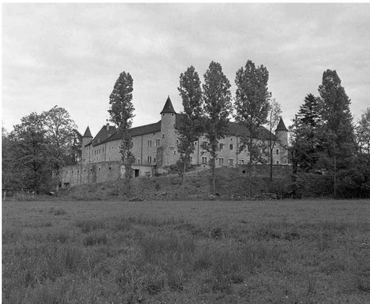
Façades nord et ouest.
