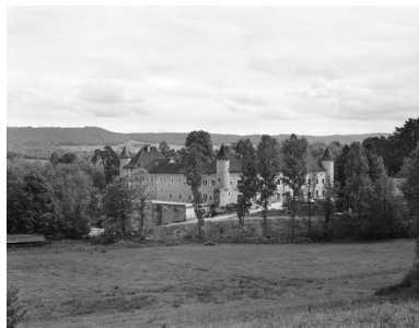
Vue de situation depuis l'ouest. Phot. Yves Sancey IVR43_19813900085X
