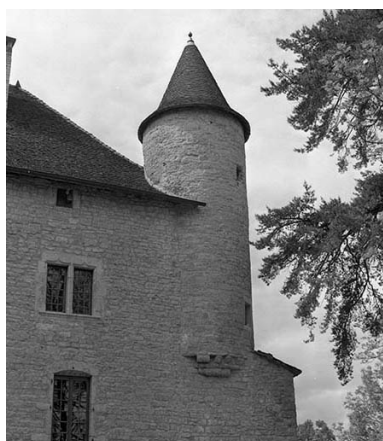
Vue générale de la tourelle de l'angle nord-est Phot. Yves Sancey IVR43_19813900089X
