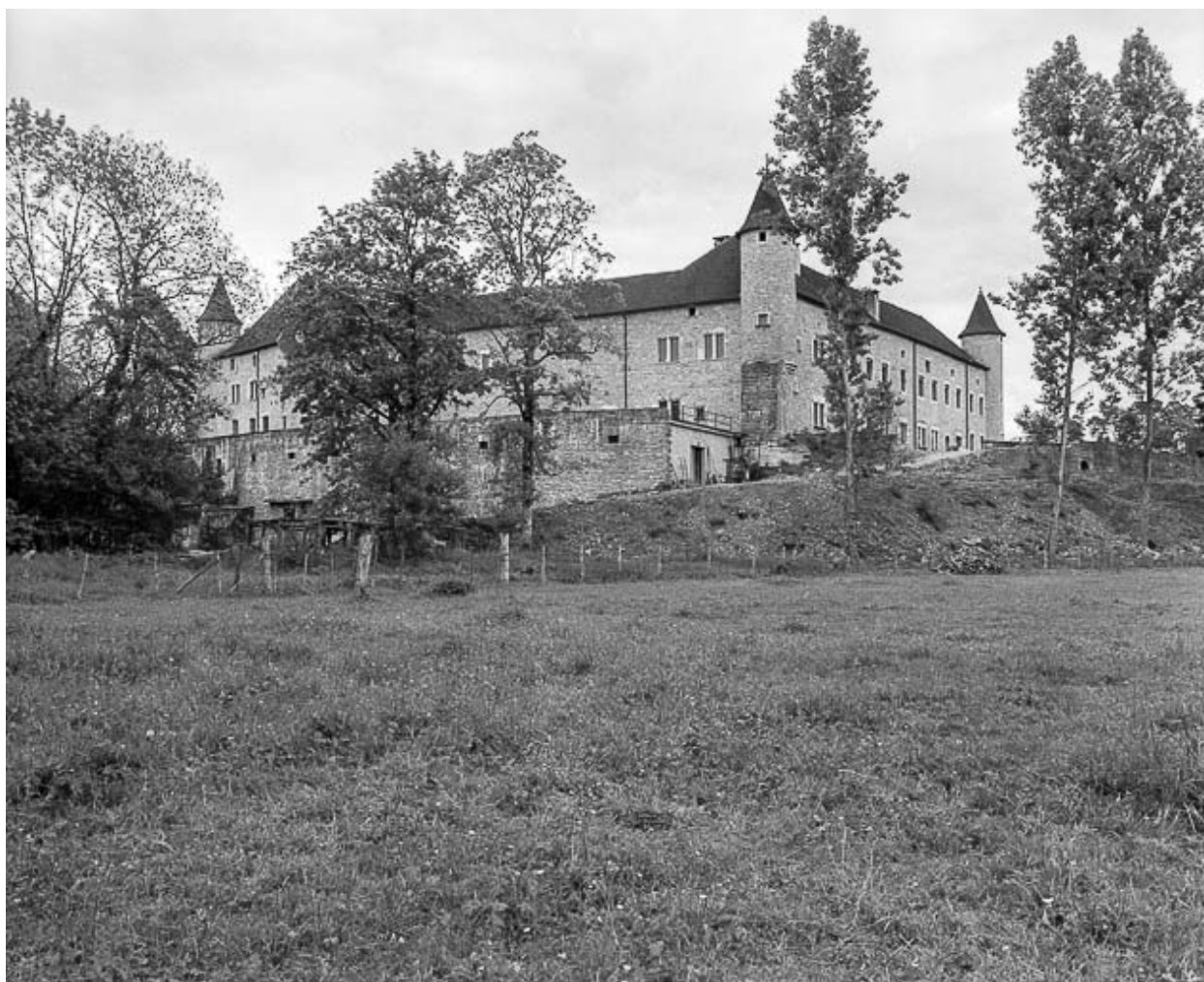
Façades nord et ouest.
