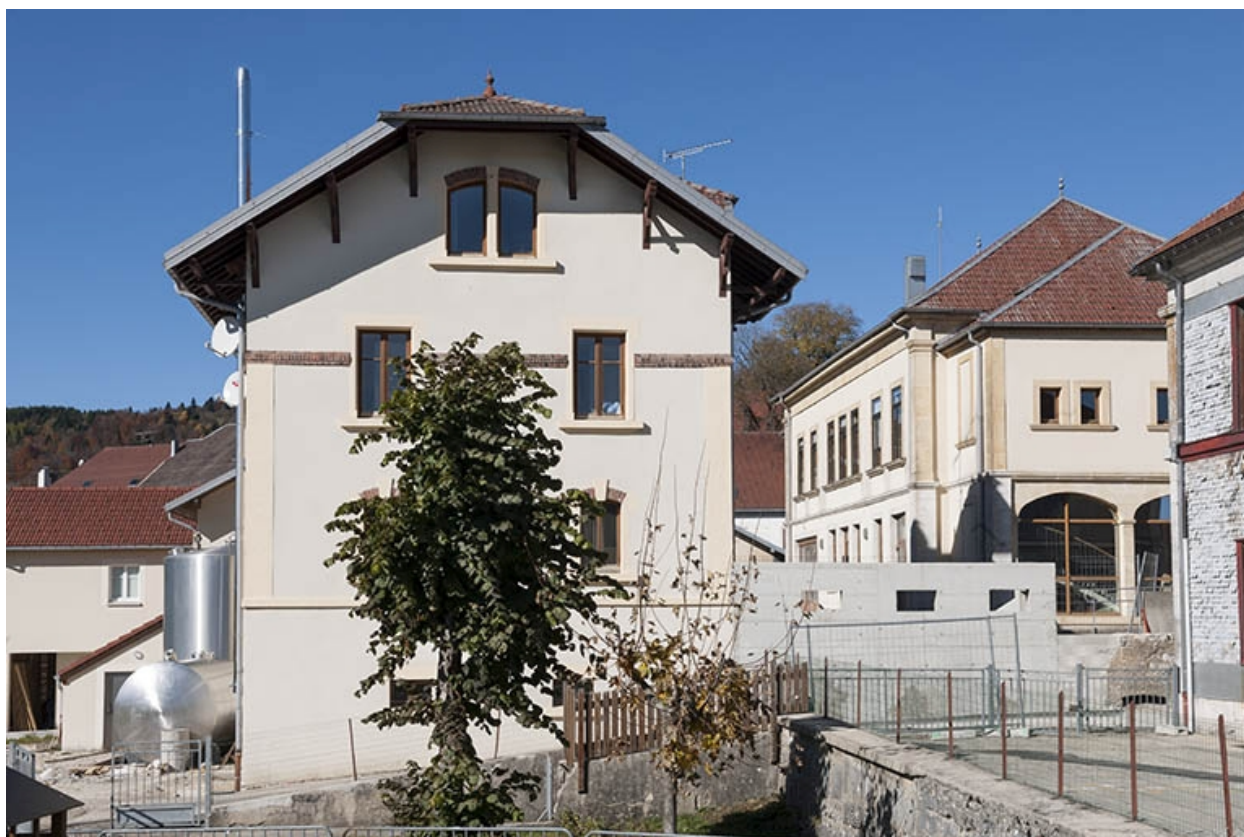
Vue depuis le sud-est.
