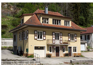
Maison, de trois quarts gauche. Phot. Sonia Dourlot IVR43_20172500393NUC4A
