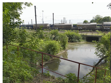
Sortie de l'aqueduc du ruisseau du Préblin, la rigole d'évacuation du canal le rejoint sur la gauche pour passer sous les voies ferrées. Phot. Thierry Kuntz IVR26_20118900234NUC4A
