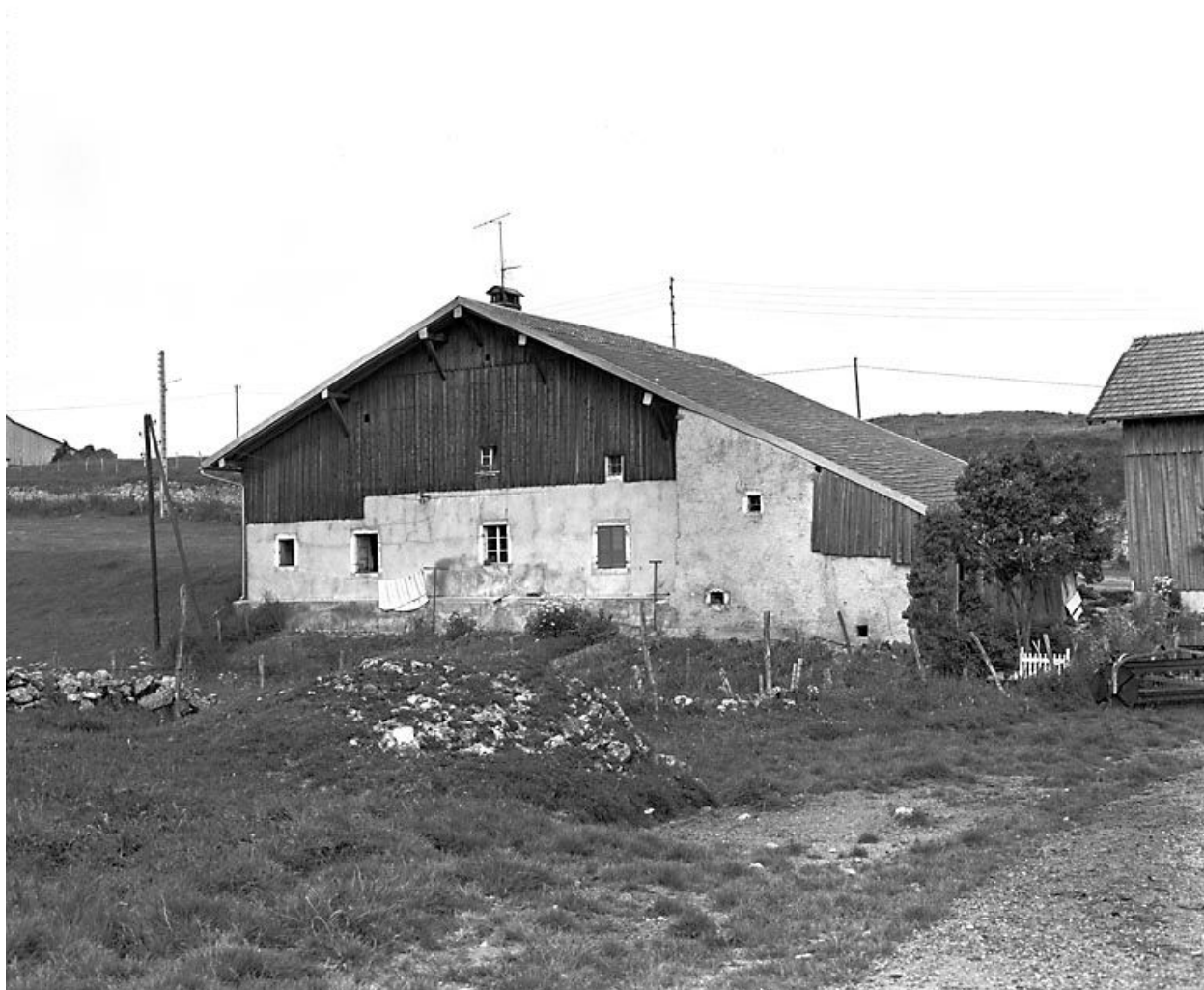
Façade latérale gauche.
