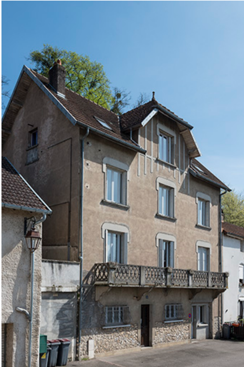
Façade principale du pavillon.
