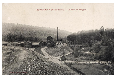
Ronchamp (Haute-Saône). - Le puits du Magny. Phot. Jérôme Mongreville IVR43_20057000644NUCA
