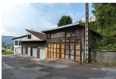
Garages, depuis le nord-est. Phot. Sonia Dourlot IVR43_20172501044NUC4A
