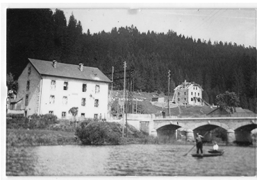
[La maison d'Emile Remonay en construction], vers 1925-1926. Autr. auteur inconnu IVR43_20172500871NUC4A
