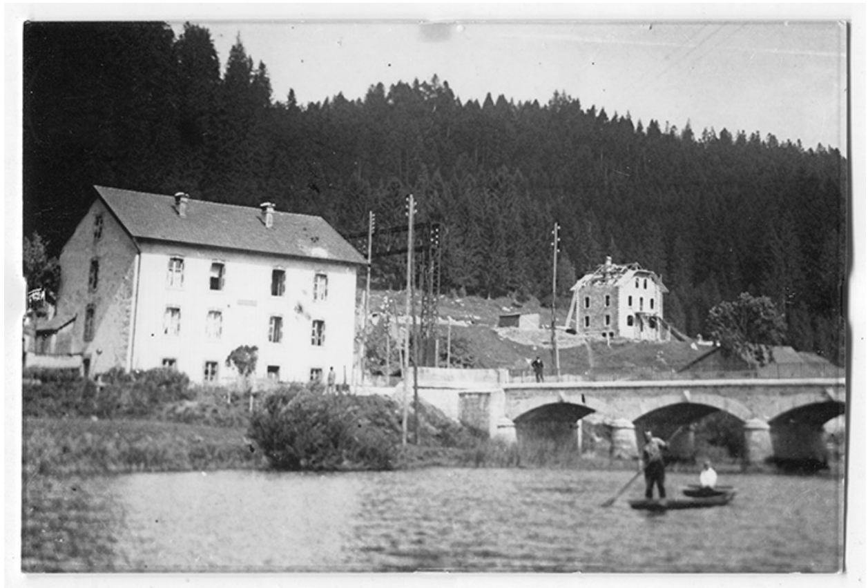
[La maison d'Emile Remonay en construction], vers 1925-1926.
