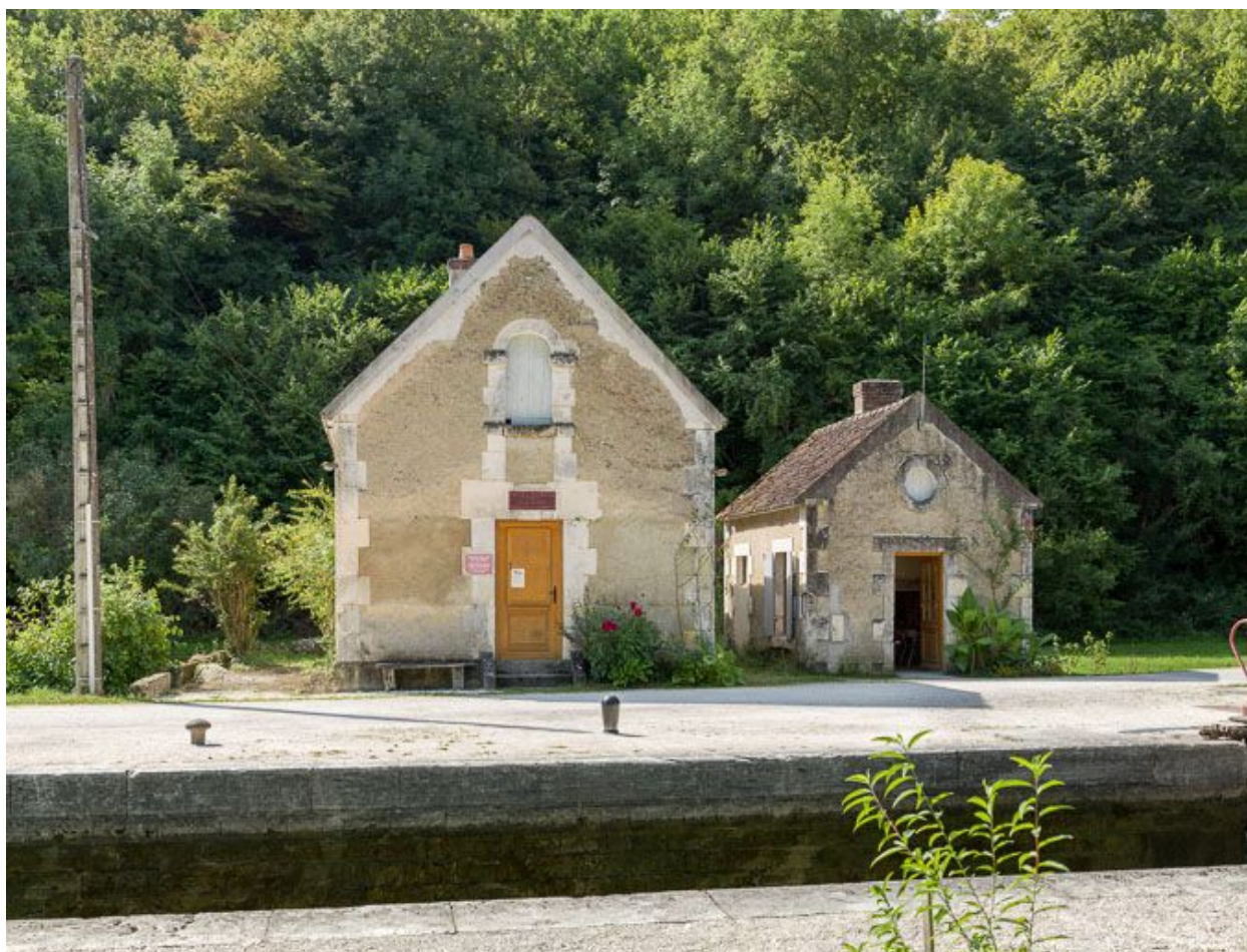
Vue de la maison éclusière de face.
