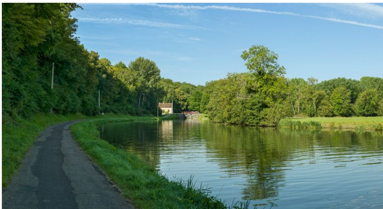
Vue d'ensemble du site pris d'aval.
