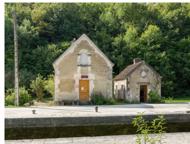
Vue de la maison éclusière de face. Phot. Pierre-Marie Barbe-Richaud IVR26_20138900128NUC4AQ
