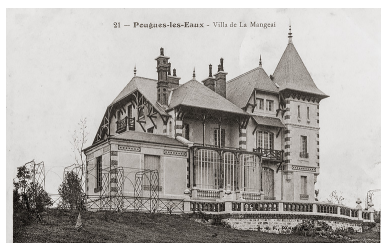
Façades nord et ouest.
