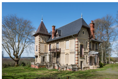
Façades sud et est.
