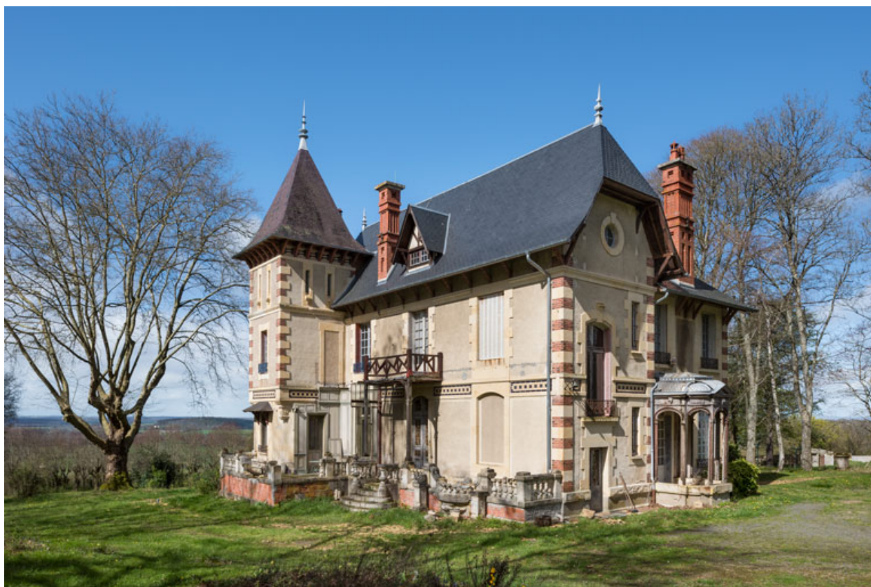
Façades sud et est.
