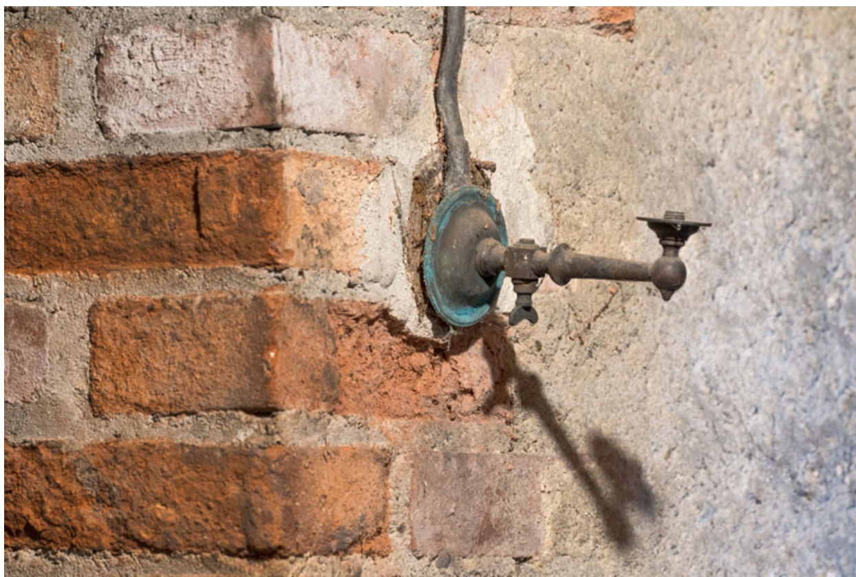
Luminaire d'applique au sous-sol.
