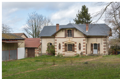
Conciergerie et communs. Phot. Pierre-Marie Barbe-Richaud IVR26_20245800177NUC4A
