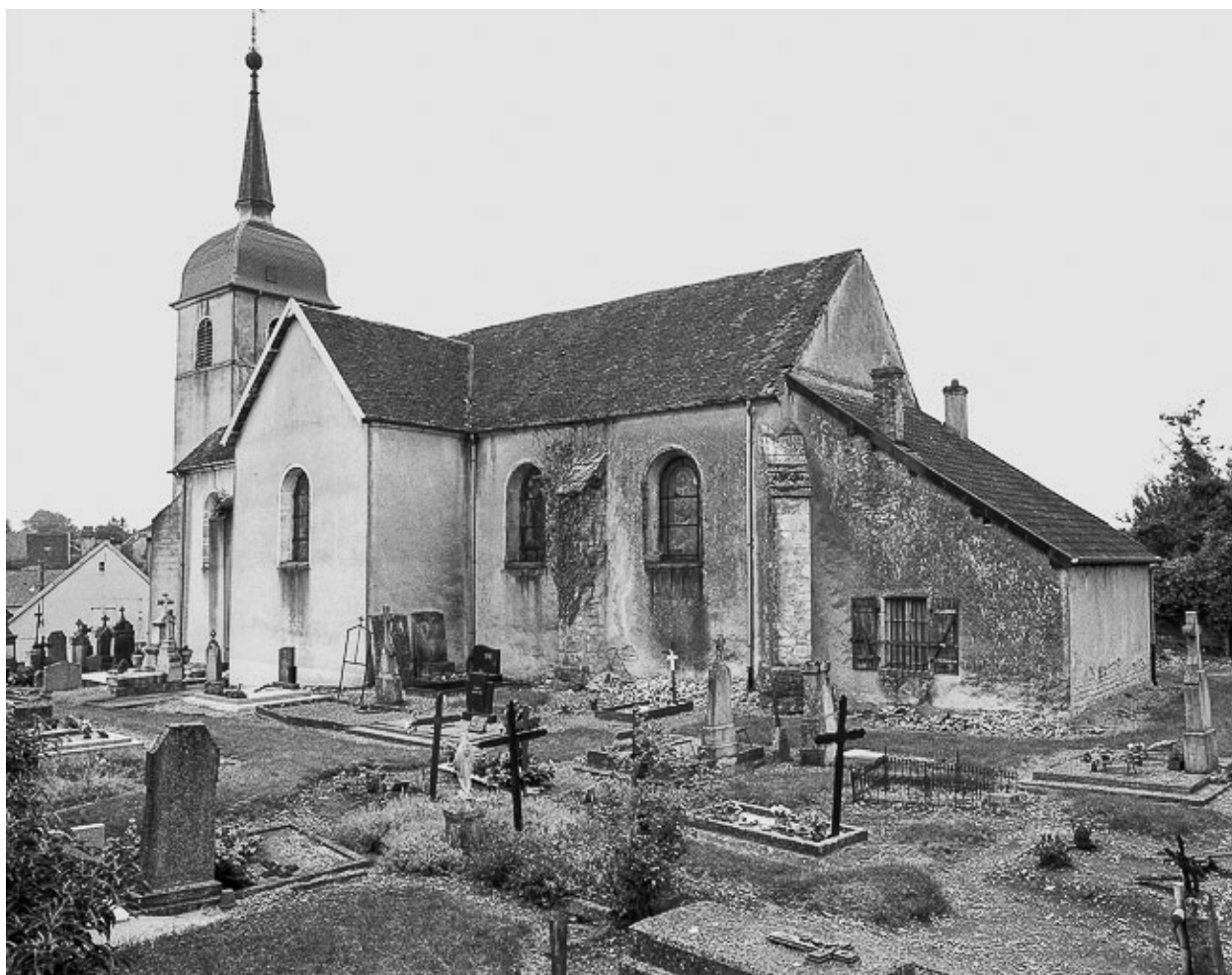
Façade latérale droite, chevet et sacristie.
