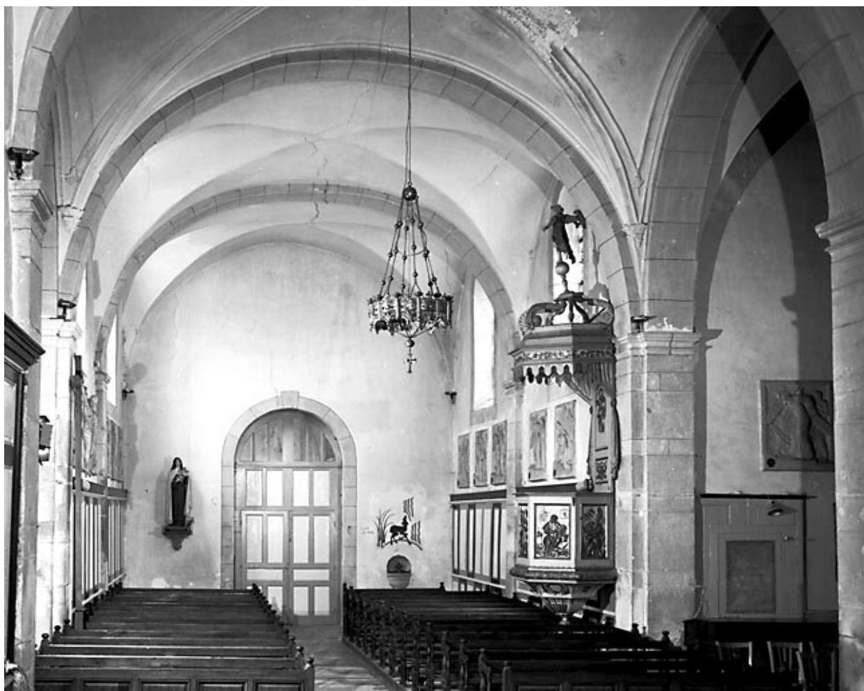
Vue de la nef depuis le chœur.
