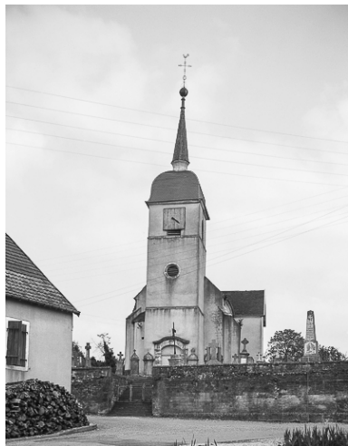
Façade antérieure avec tour-clocher. Phot. Yves Sancey IVR43_19837000059V
