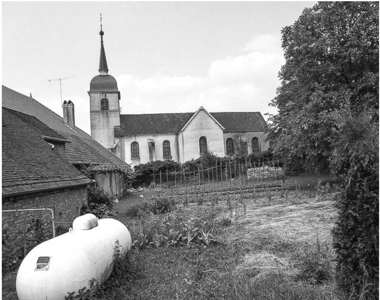
Façade latérale droite.
