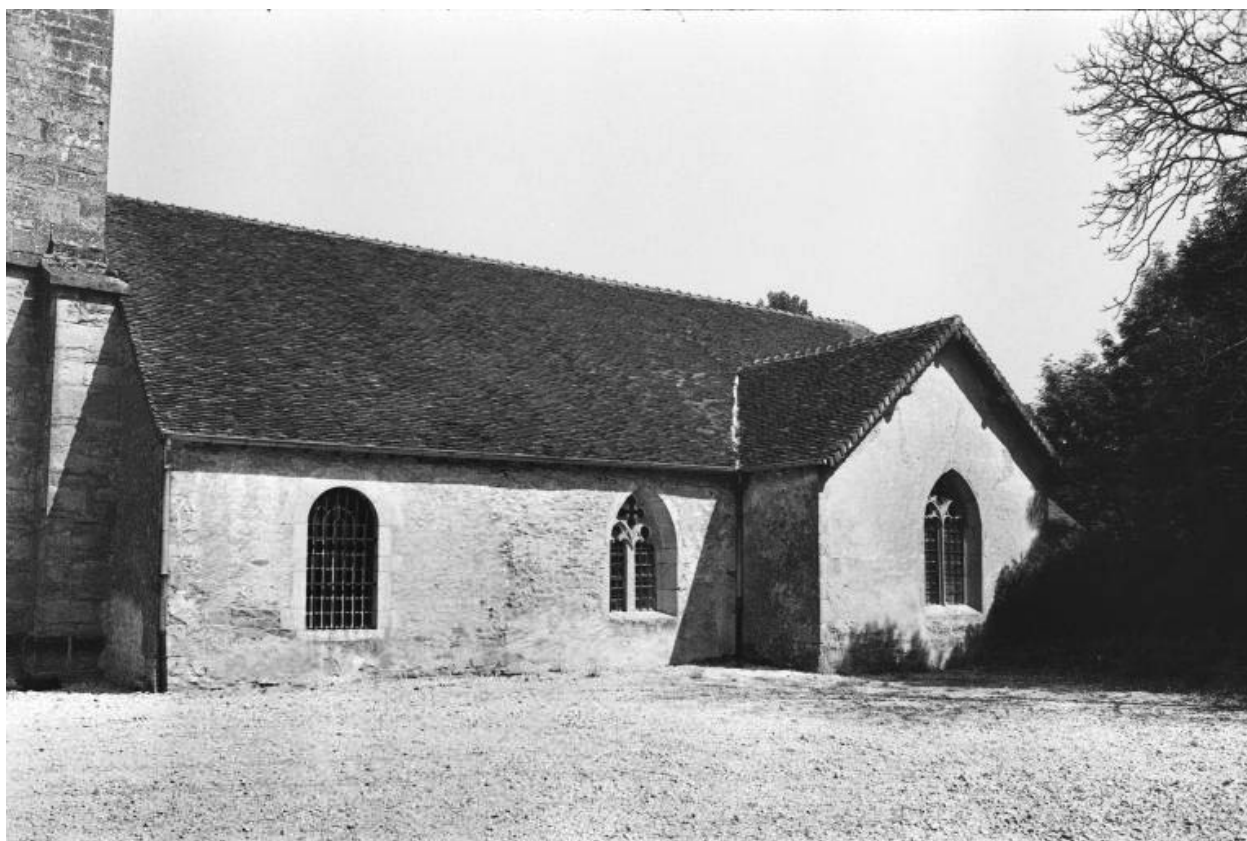
Façade latérale droite.
