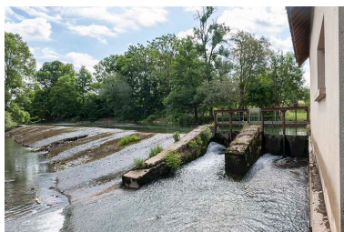
La barrage depuis l'aval et le vannage de décharge. Phot. Jérôme Mongreville IVR43_20152501230NUC4A
