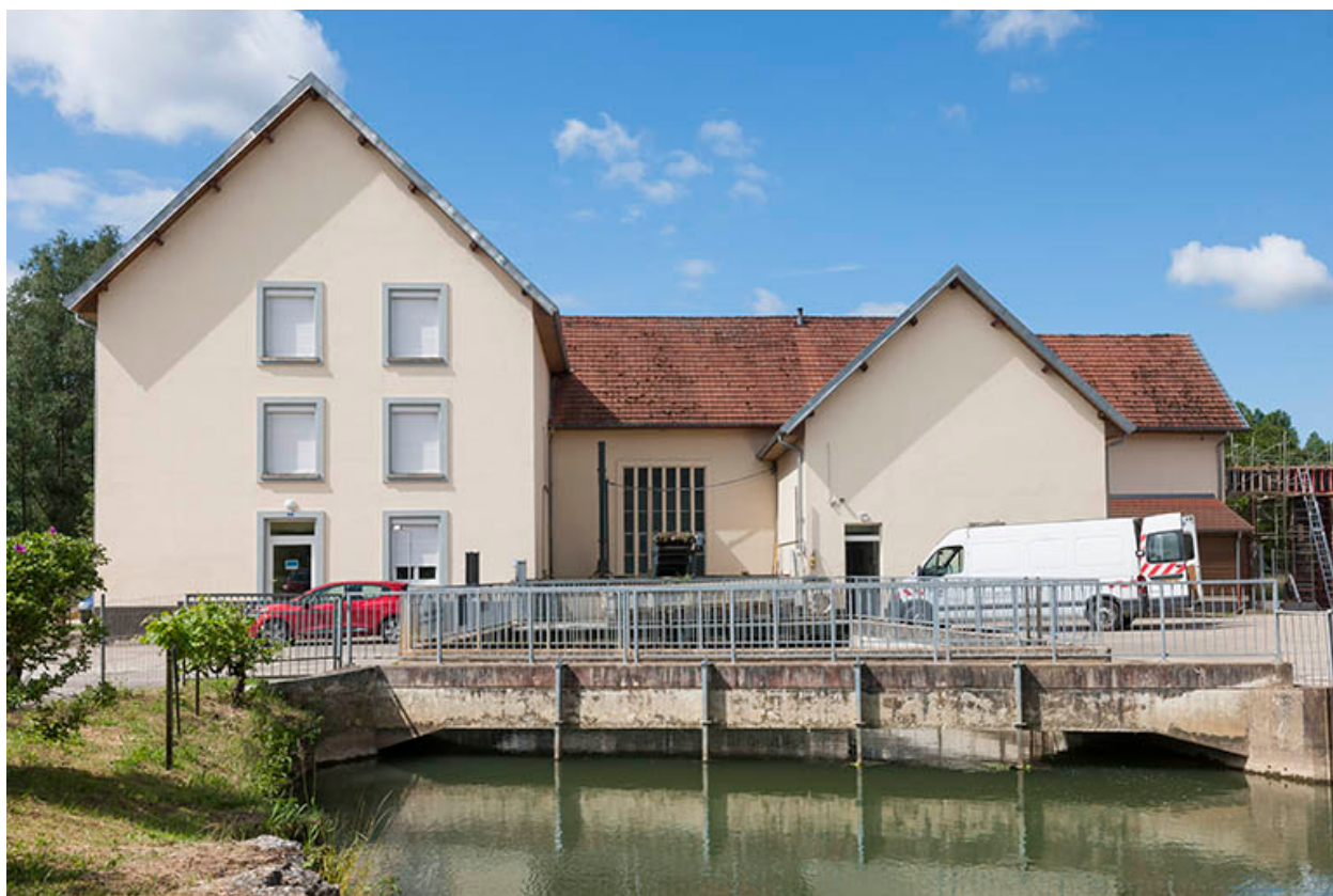
La centrale hydroélectrique depuis le canal d'amenée.
