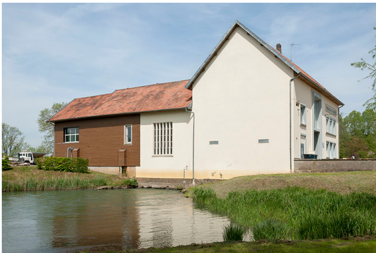
La centrale hydroélectrique vue depuis le sud.
