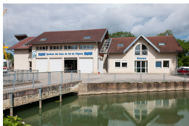
Les garages et bureaux du Sievo. Phot. Jérôme Mongreville IVR43_20152501228NUC4A
