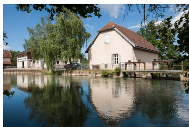
Vue depuis le début du canal d'amenée. Phot. Jérôme Mongreville IVR43_20152501233NUC4A
