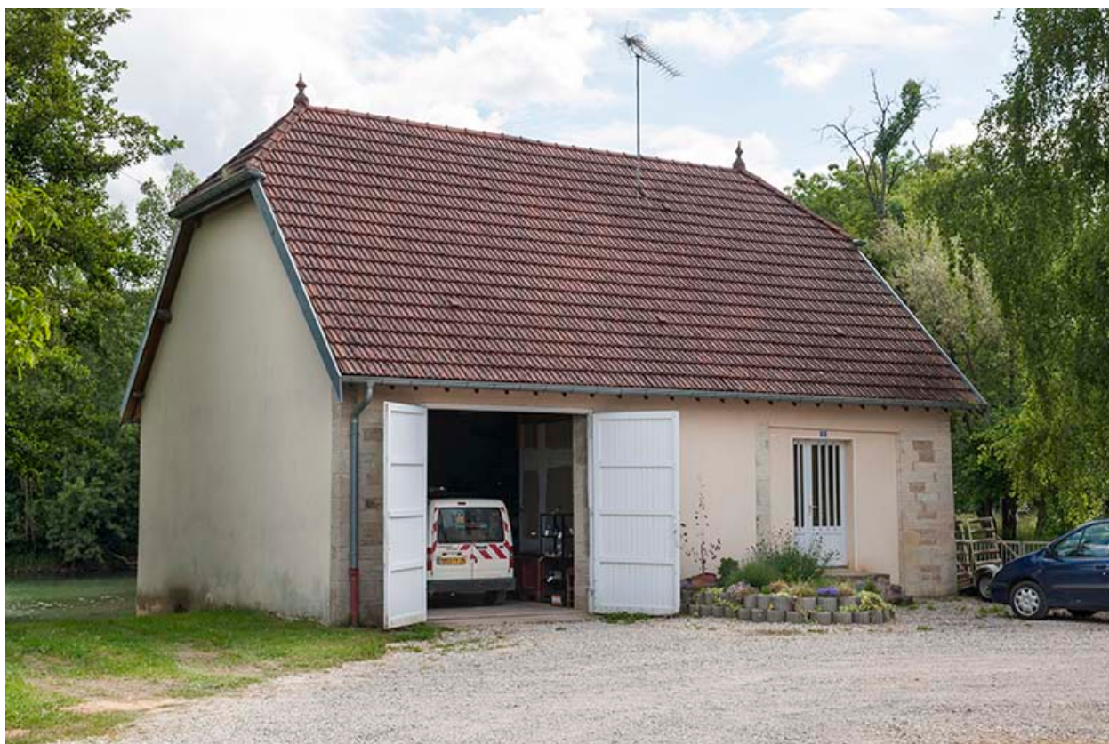
Garage et logement (ancien atelier de scierie).
