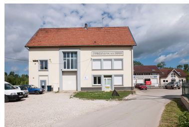
Vue d'ensemble depuis l'arrivée. Phot. Jérôme Mongreville IVR43_20152501229NUC4A
