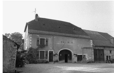
Ferme située rue Basse. Phot. Bernard Lardière IVR43_19797000215Z
