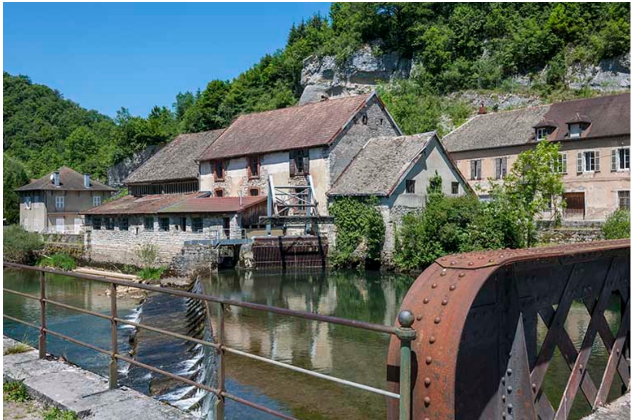
Vue d'ensemble depuis le pont, rive gauche.
