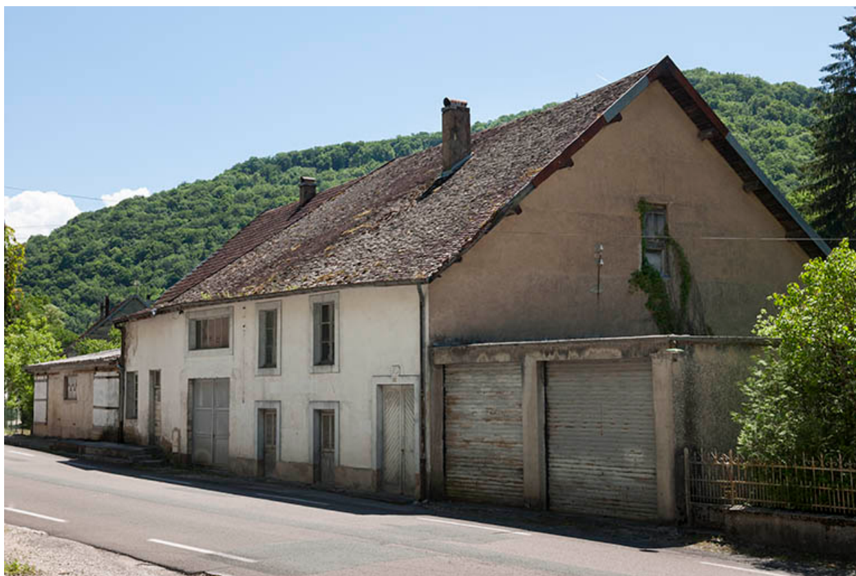
Vue rapprochée depuis le nord-ouest.
