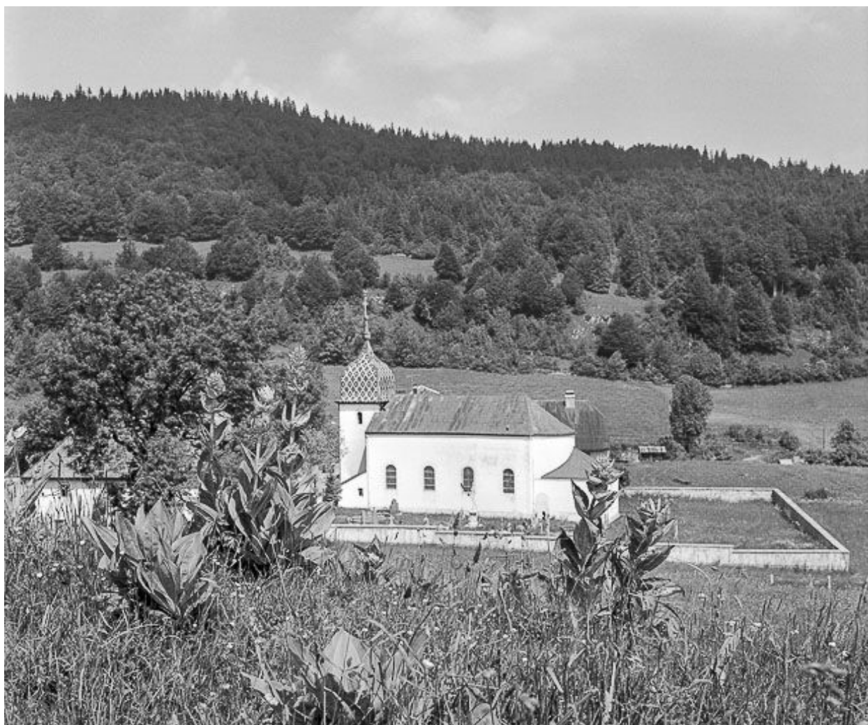
Vue d'ensemble dans le site.
