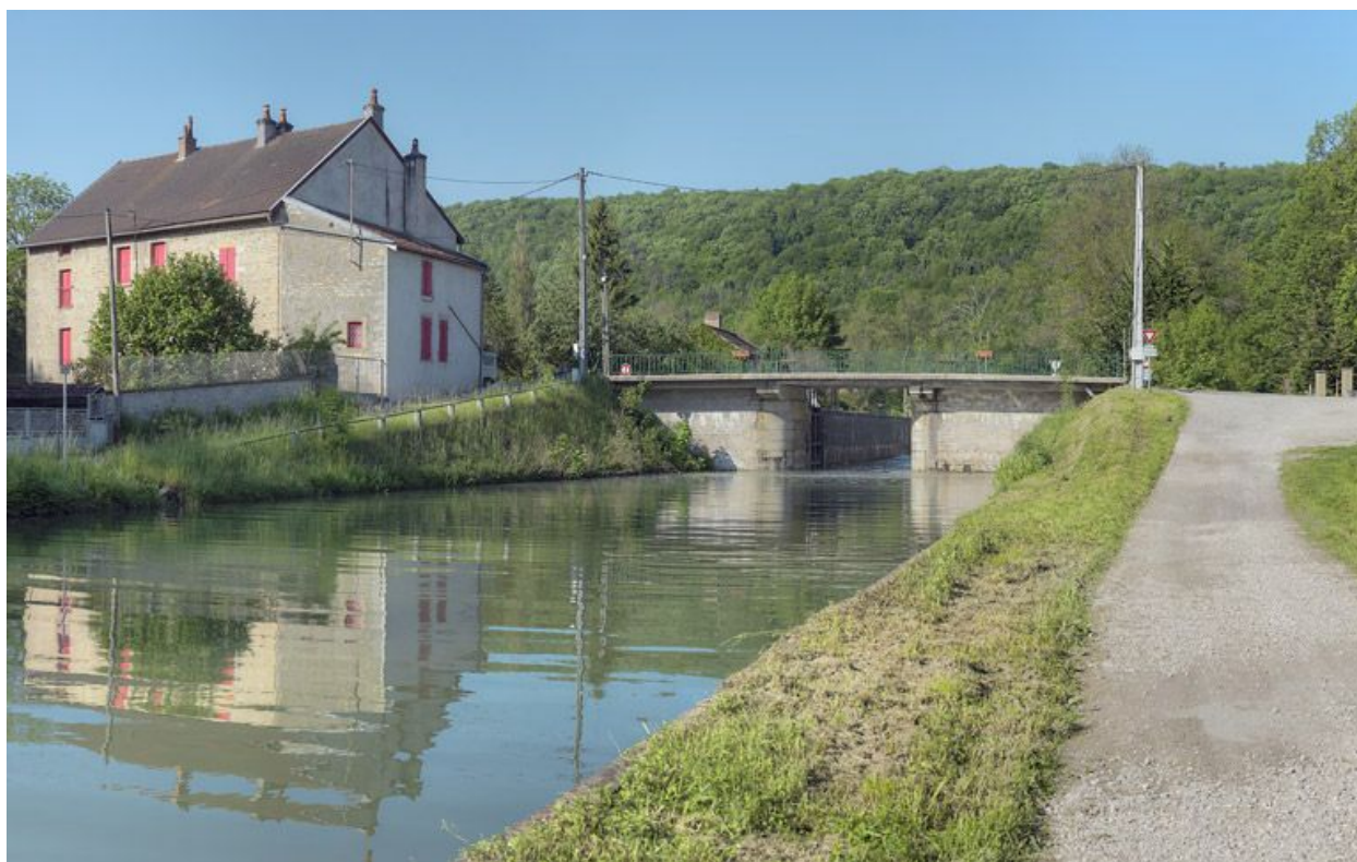
Le pont vu d'aval.
