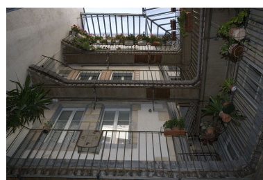
Vue d'ensemble de la cour. Phot. Yves Sancey IVR43_20082500391NUC2A
