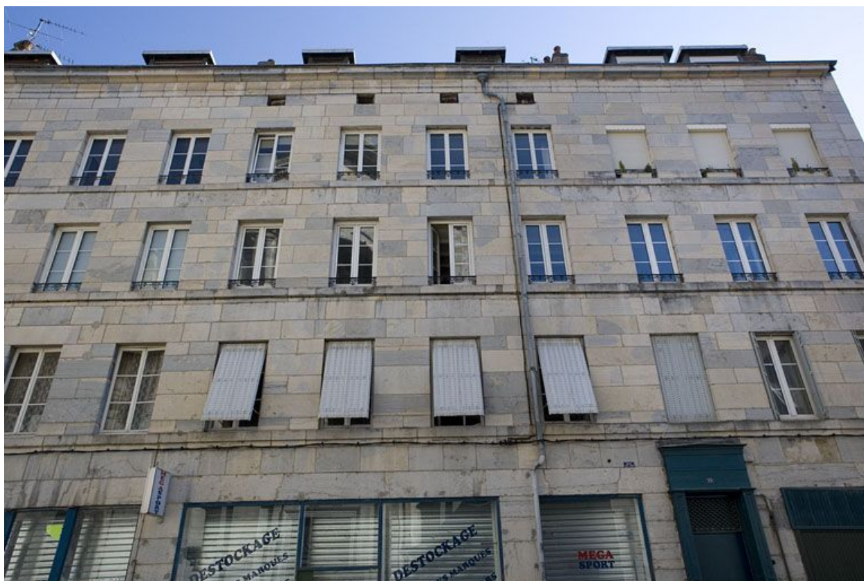
Vue d'ensemble de face depuis la rue.
