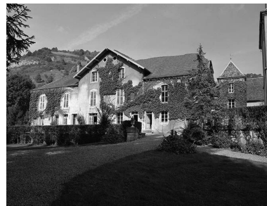
Façade antérieure du logement du gardien. Phot. Yves Sancey IVR43_19802501366X
