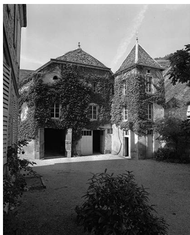
Face latérale droite du logement du gardien. Phot. Yves Sancey IVR43_19802501367X
