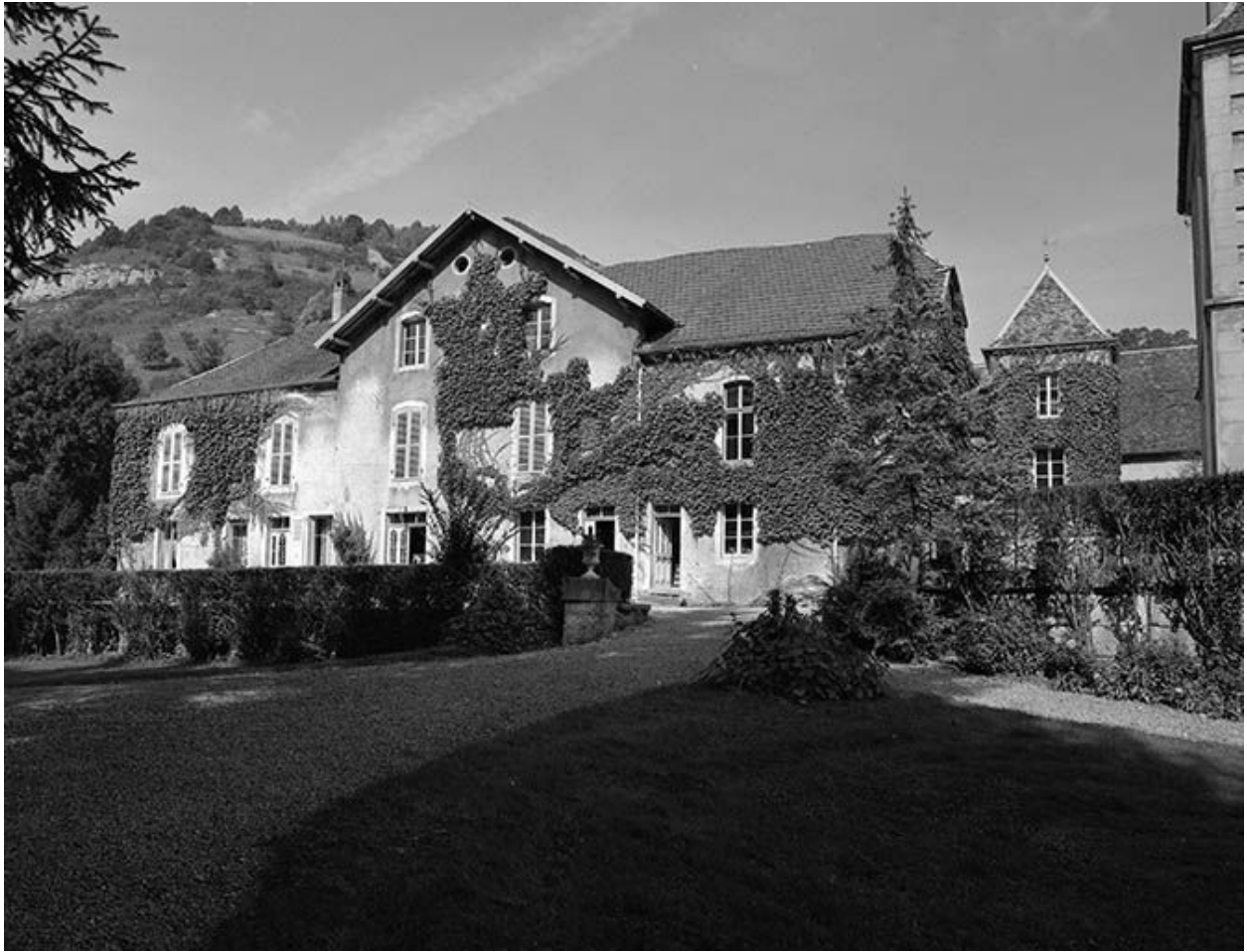
Façade antérieure du logement du gardien.
