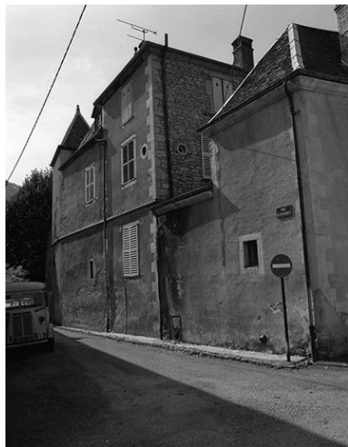
Face latérale gauche. Phot. Yves Sancey IVR43_19802501364X
