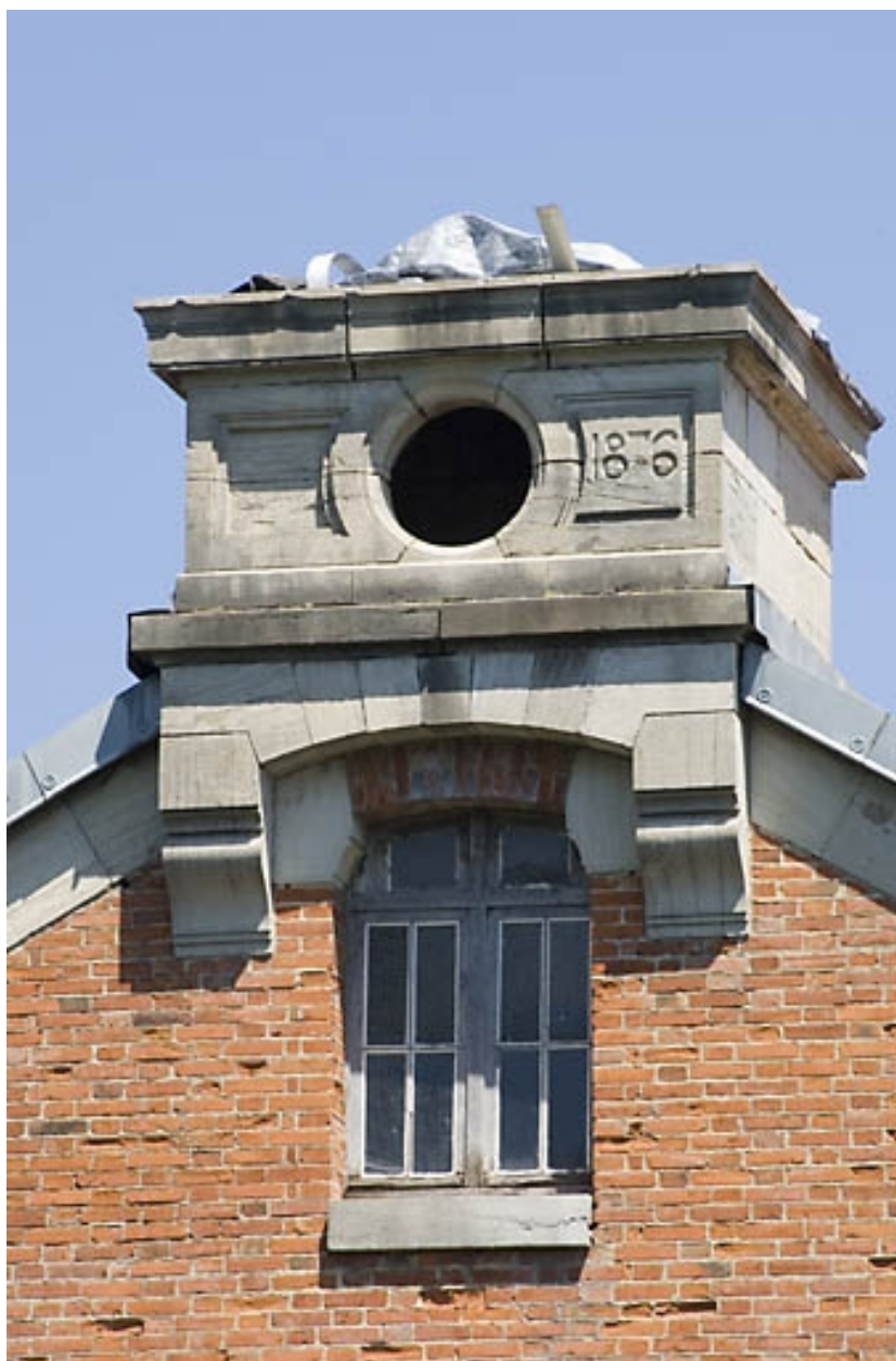
Couronnement de façade sud du bâtiment d'eau.
