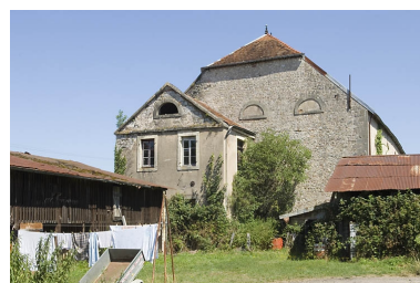
Le haut fourneau vu depuis le sud. Phot. Jérôme Mongreville IVR43_20087000888NUC2A
