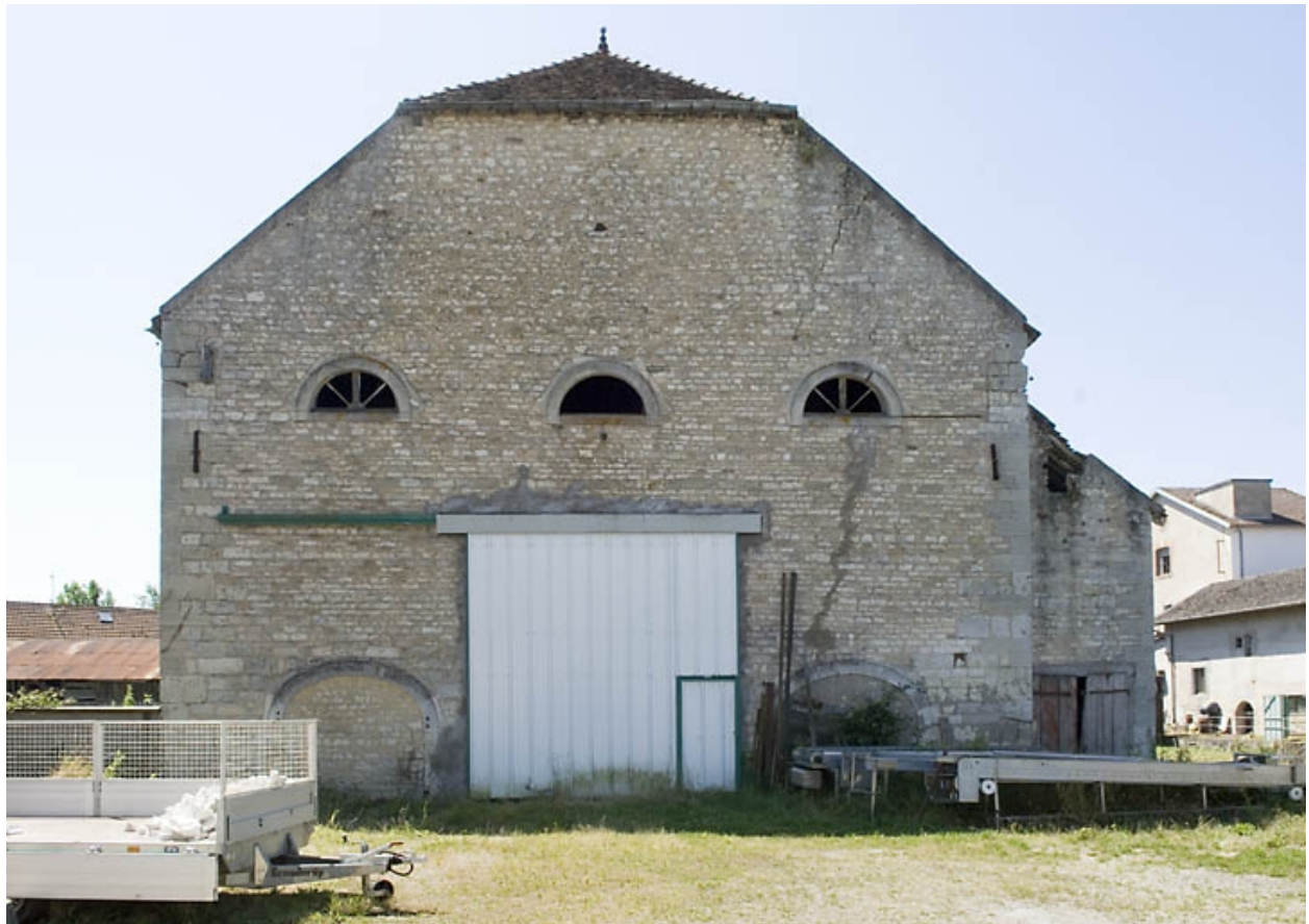
Mur-pignon nord du haut fourneau.
