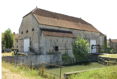
Vue du haut fourneau depuis l'ouest. Phot. Jérôme Mongreville IVR43_20087000901NUC2A
