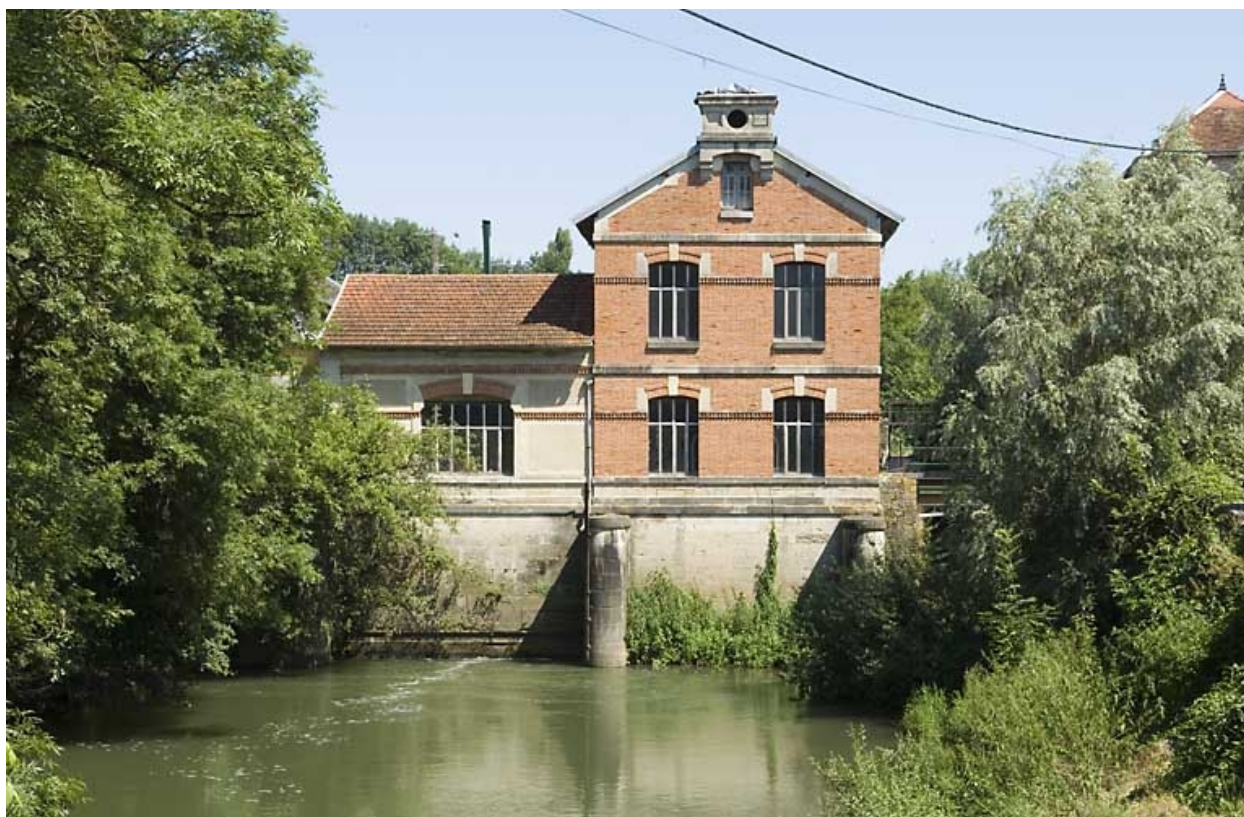
Vue rapprochée du bâtiment d'eau.
