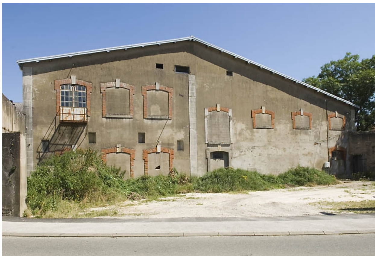
Façade sud d'ateliers de la papeterie.
