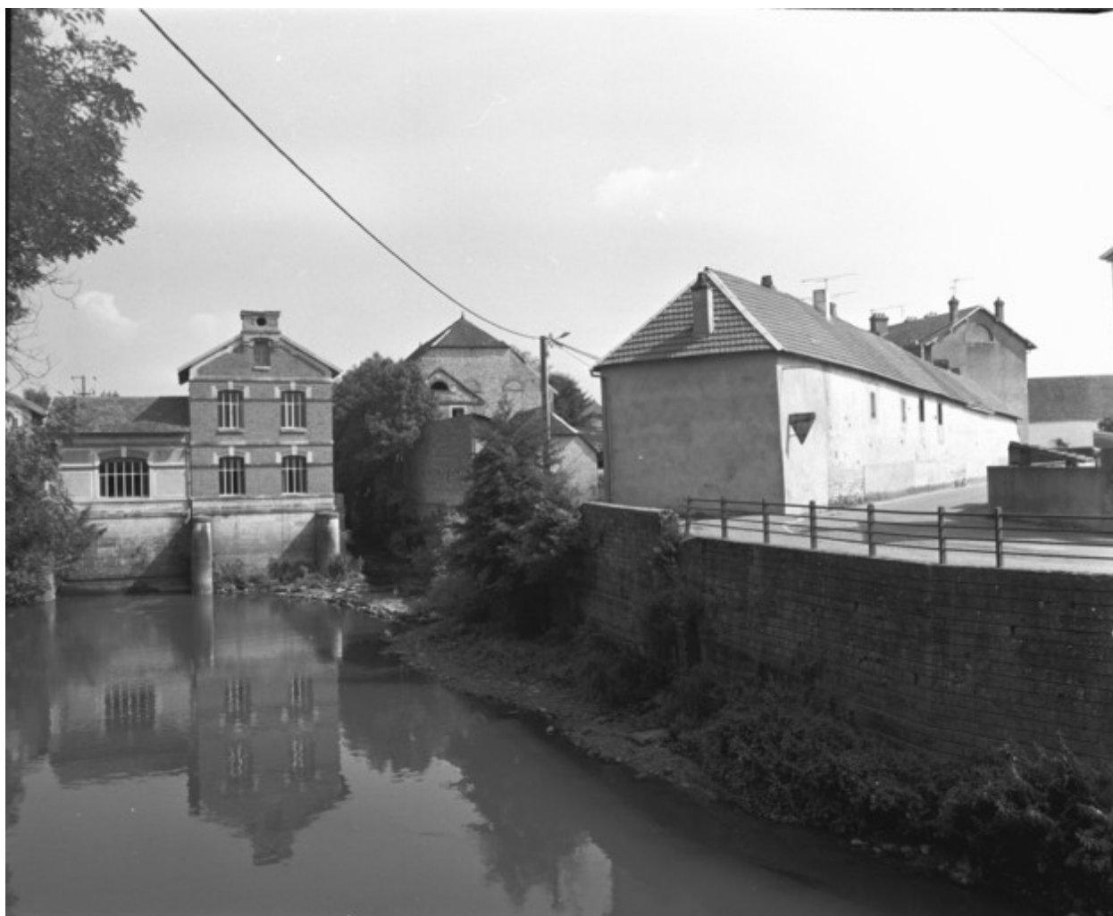
Vue d'ensemble depuis la rue en 1989.
