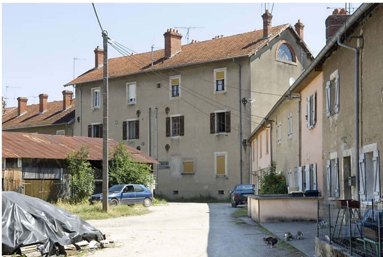
Façade ouest du logement ouvrier sur cour.
