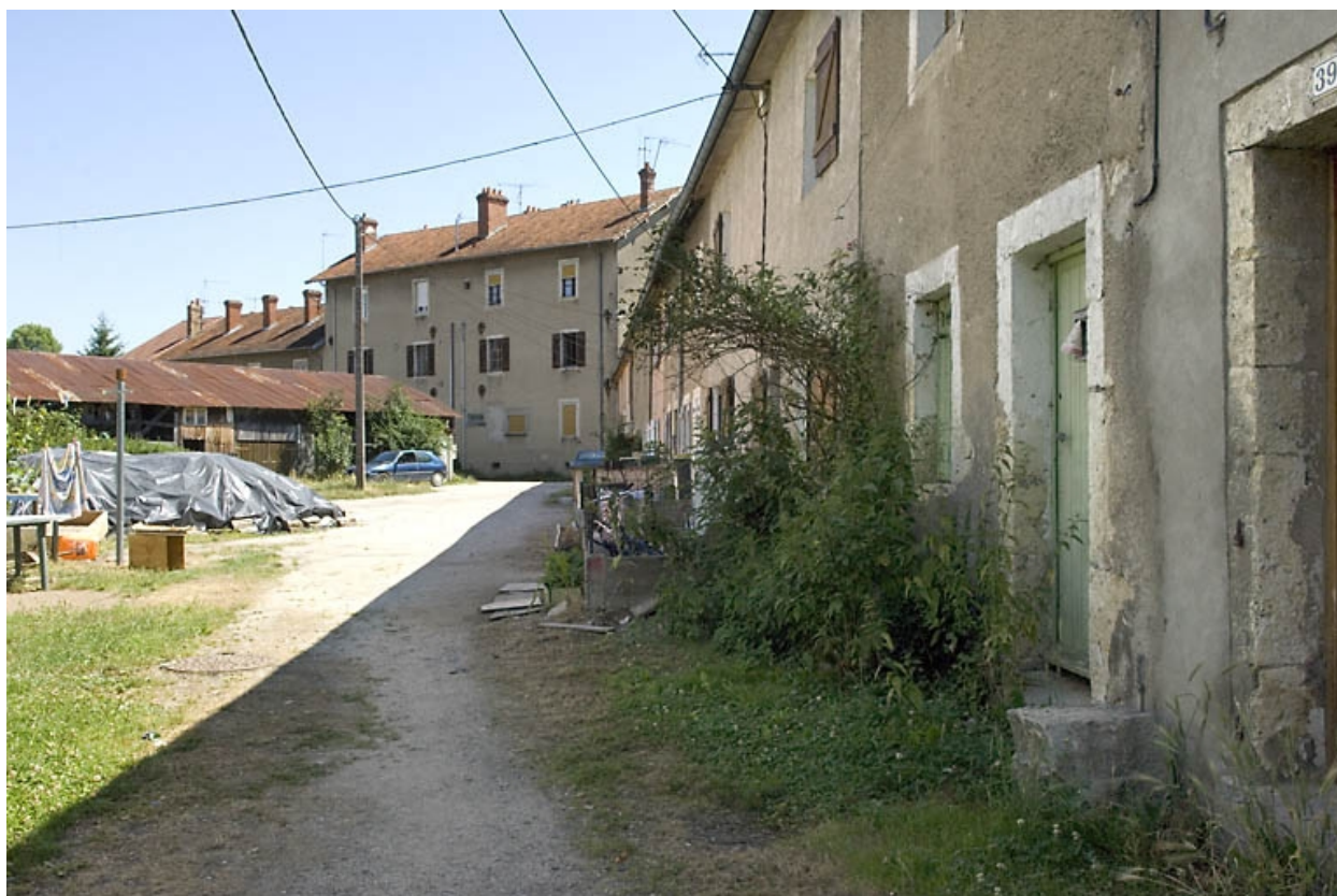
Logements ouvriers sur cour.
