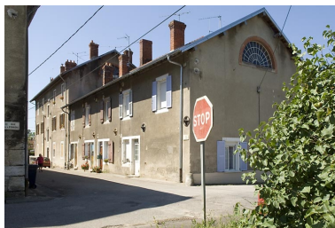
Logement ouvrier rue du Cornot. Phot. Jérôme Mongreville IVR43_20087000890NUC2A
