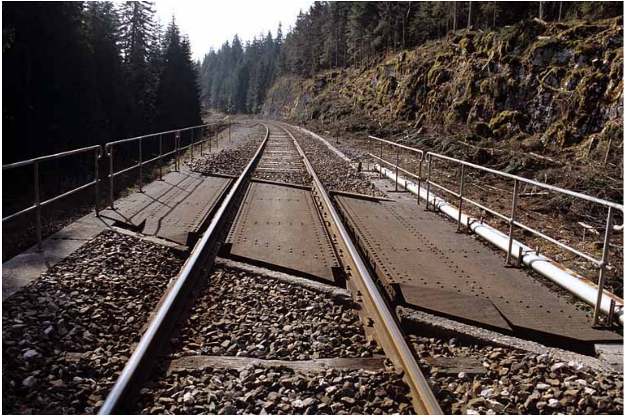
Tablier métallique, depuis la voie côté Andelot-en-Montagne.
