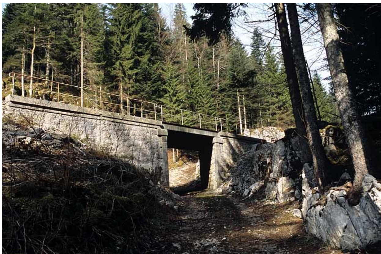
Vue d'ensemble, depuis le chemin à l'est.
