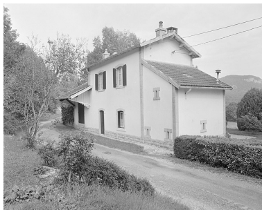
Façade sur rue. Phot. Jérôme Mongreville IVR43_19963900996X
