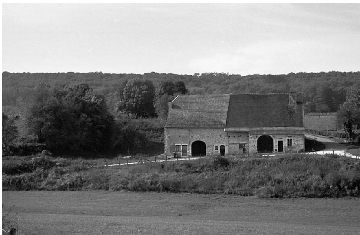
Ferme située au lieudit Les Brosses.
