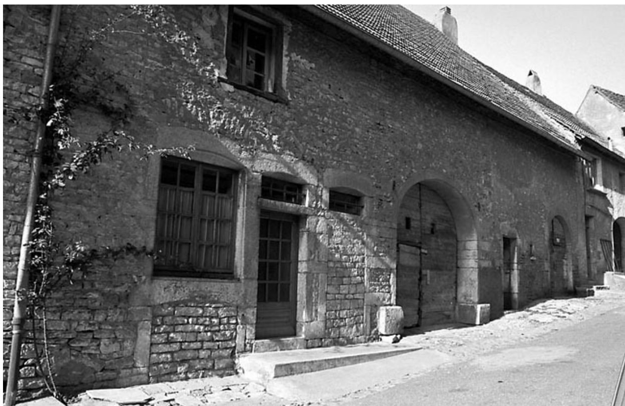
Ferme située rue Bizot.
