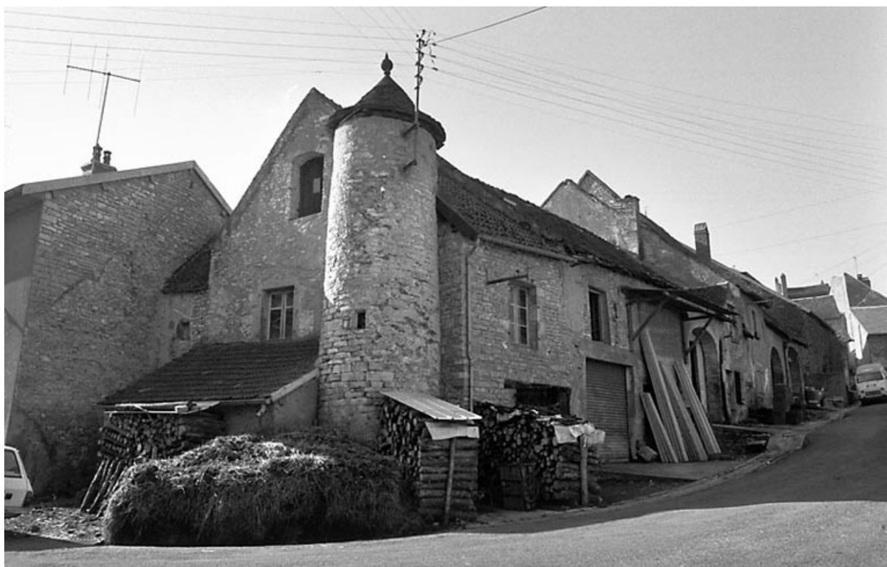
Maison située rue Gambetta.
