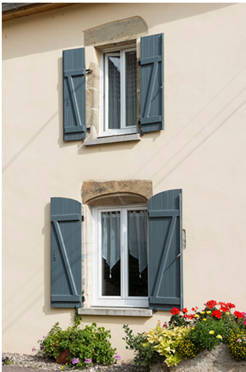
Détail sur les ouvertures, partie habitation.
