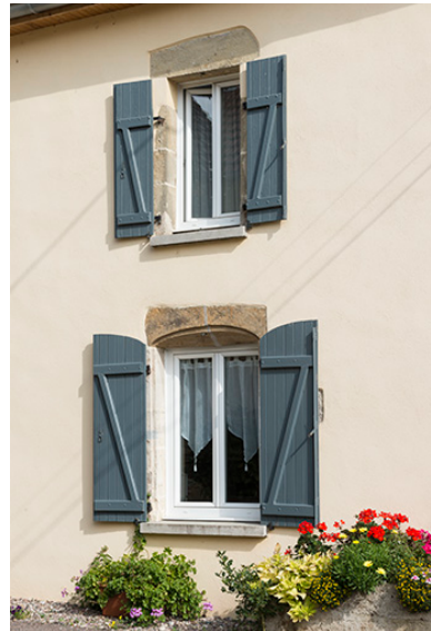
Détail sur les ouvertures, partie habitation. Phot. Jérôme Mongreville IVR43_20177000183NUC4A
