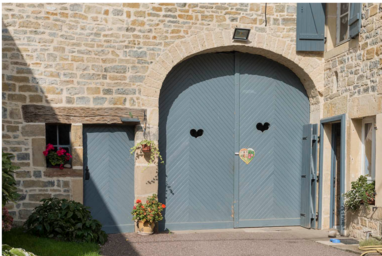
Entrées sur la partie agricole.
