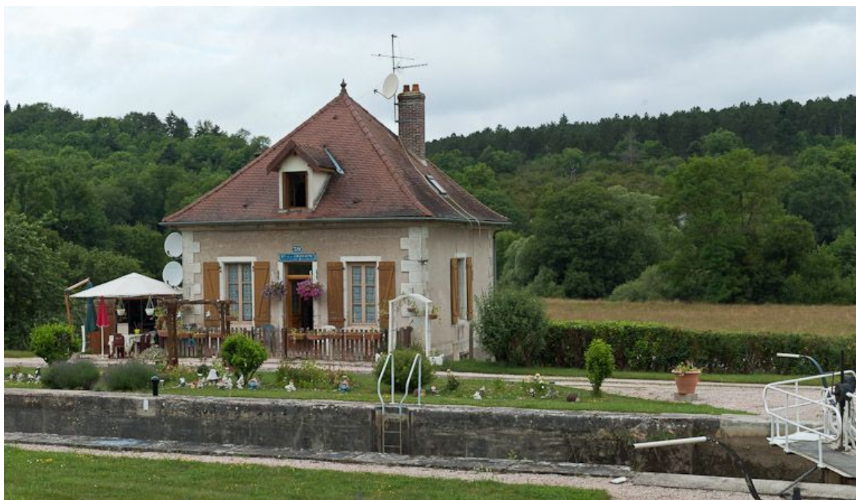
Vue de face de la maison éclusière.
