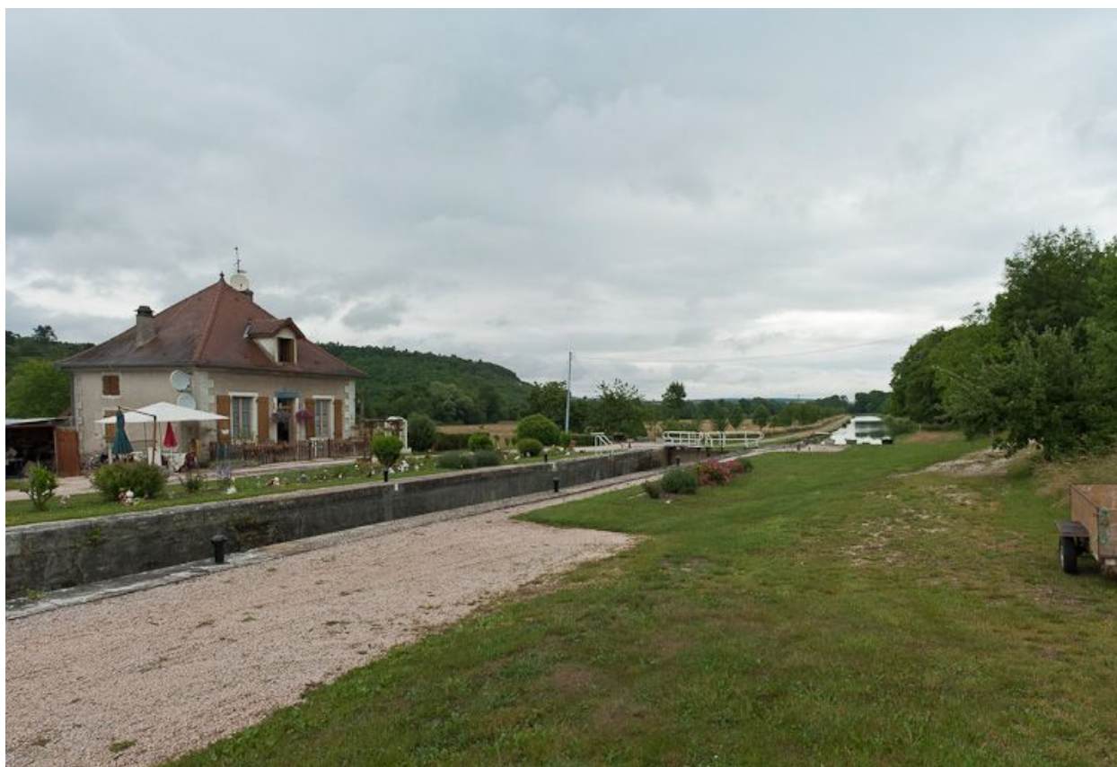
Vue d'ensemble du site d'écluse.
