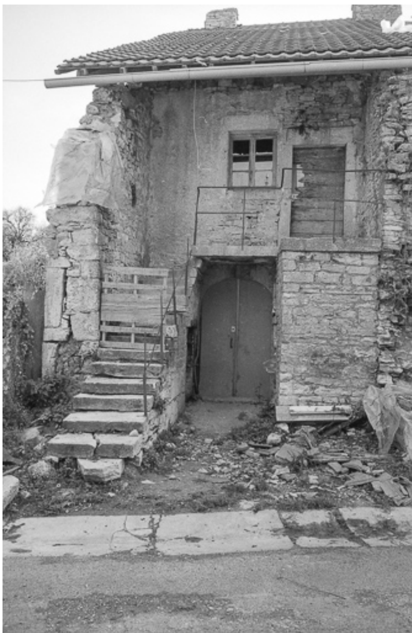
Façade antérieure, partie gauche.
