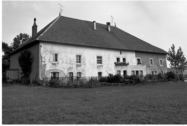
Façade antérieure. Phot. Dominique Humbert IVR43_19762500146X
