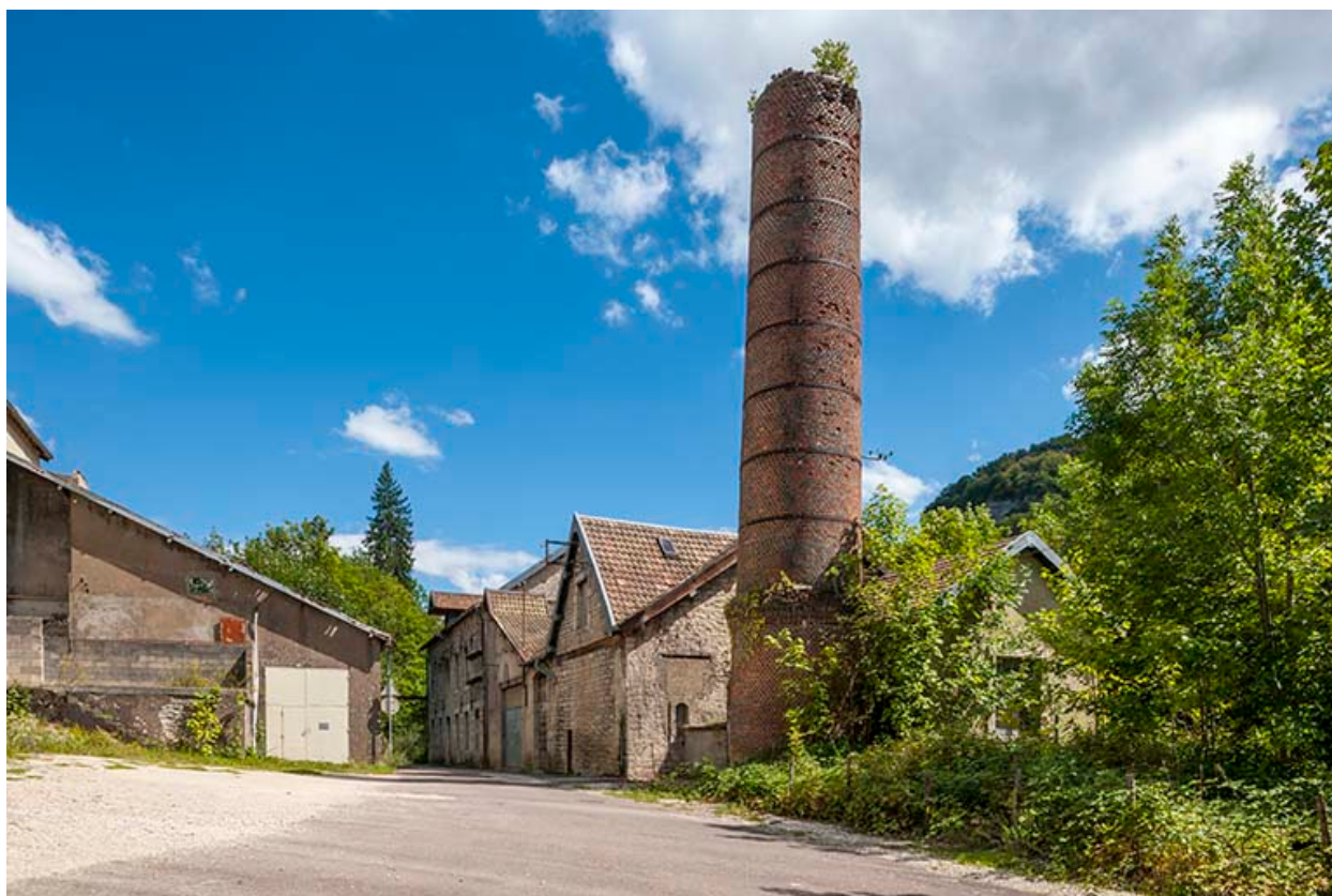
Vue des bâtiments du moulin depuis l'ouest.
