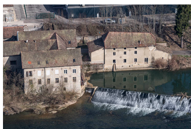
Vue plongeante rapprochée depuis le sud. Phot. Jérôme Mongreville IVR43_20152500320NUC4A
