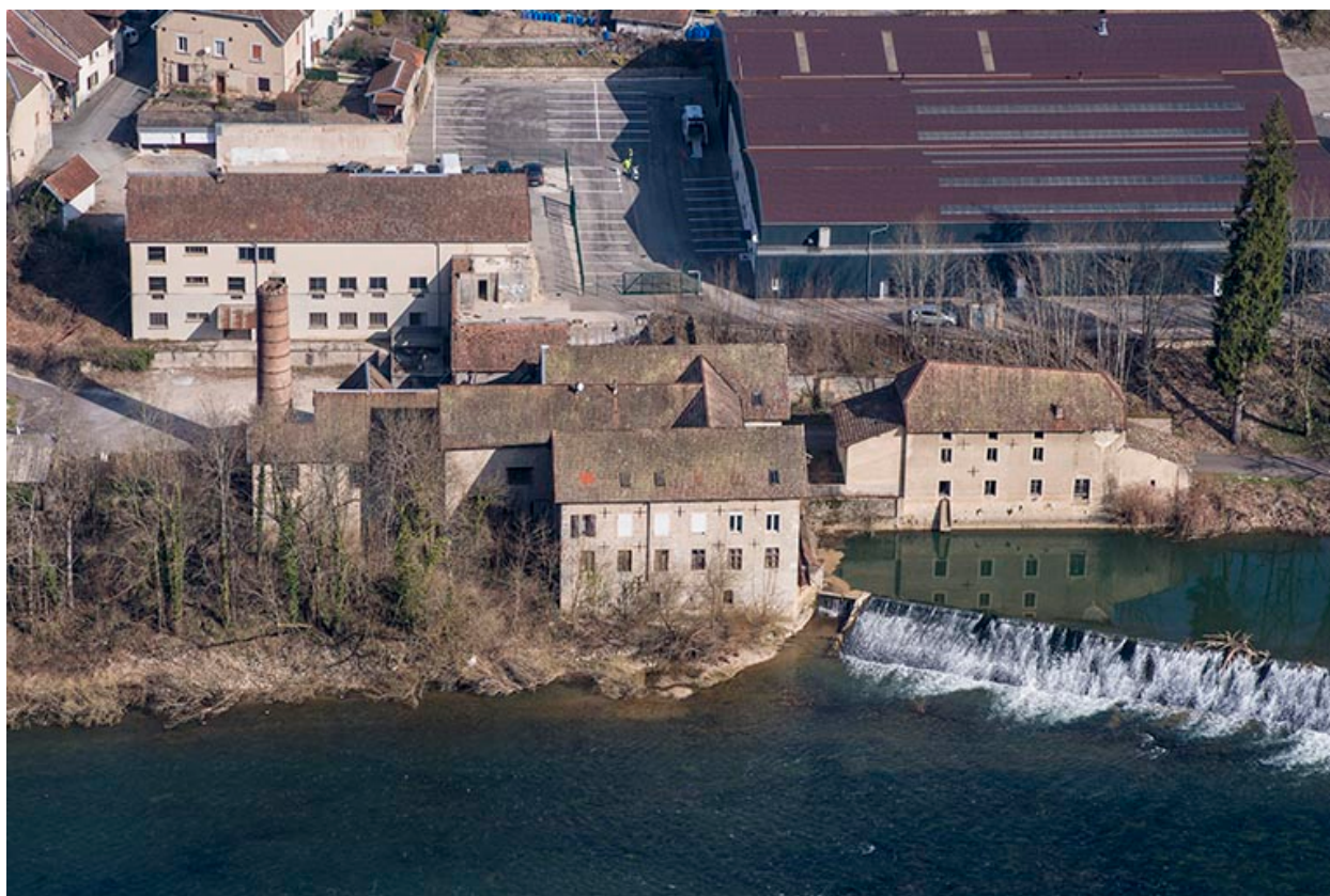
Vue plongeante depuis le sud.
