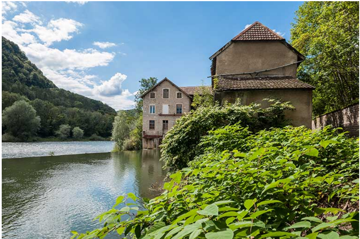
Moulin (sud) et magasin industriel depuis l'amont.
