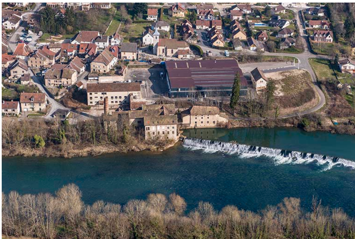
Vue d'ensemble plongeante depuis le sud.
