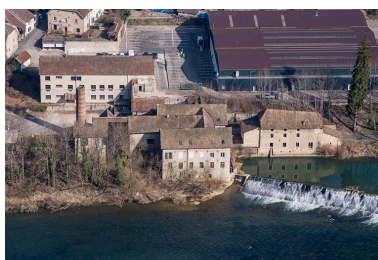
Vue plongeante depuis le sud. Phot. Jérôme Mongreville IVR43_20152500319NUC4A
