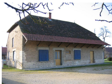
Vue d'ensemble de la façade de l'habitation.
