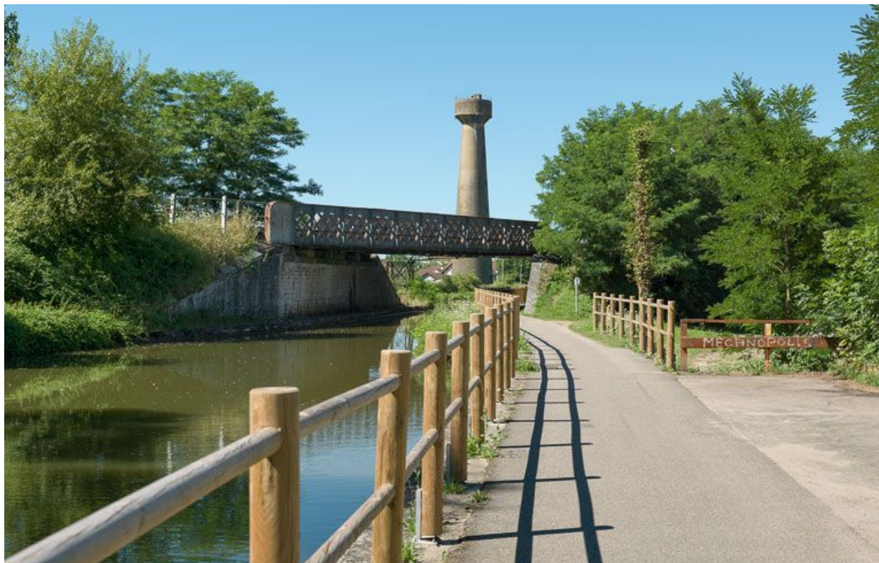
Le pont ferroviaire vu d'amont.
