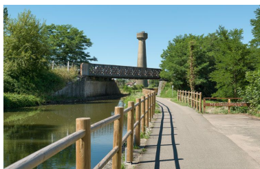
Le pont ferroviaire vu d'amont. Phot. Pierre-Marie Barbe-Richaud
