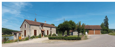
Vue d'ensemble. Phot. Thierry Kuntz IVR26_20122102046NUC4AQ
