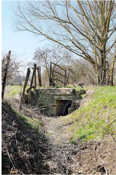
L'aqueduc, vue d'ensemble. Phot. Jean-Luc Duthu IVR26_20107100467NUC2A
