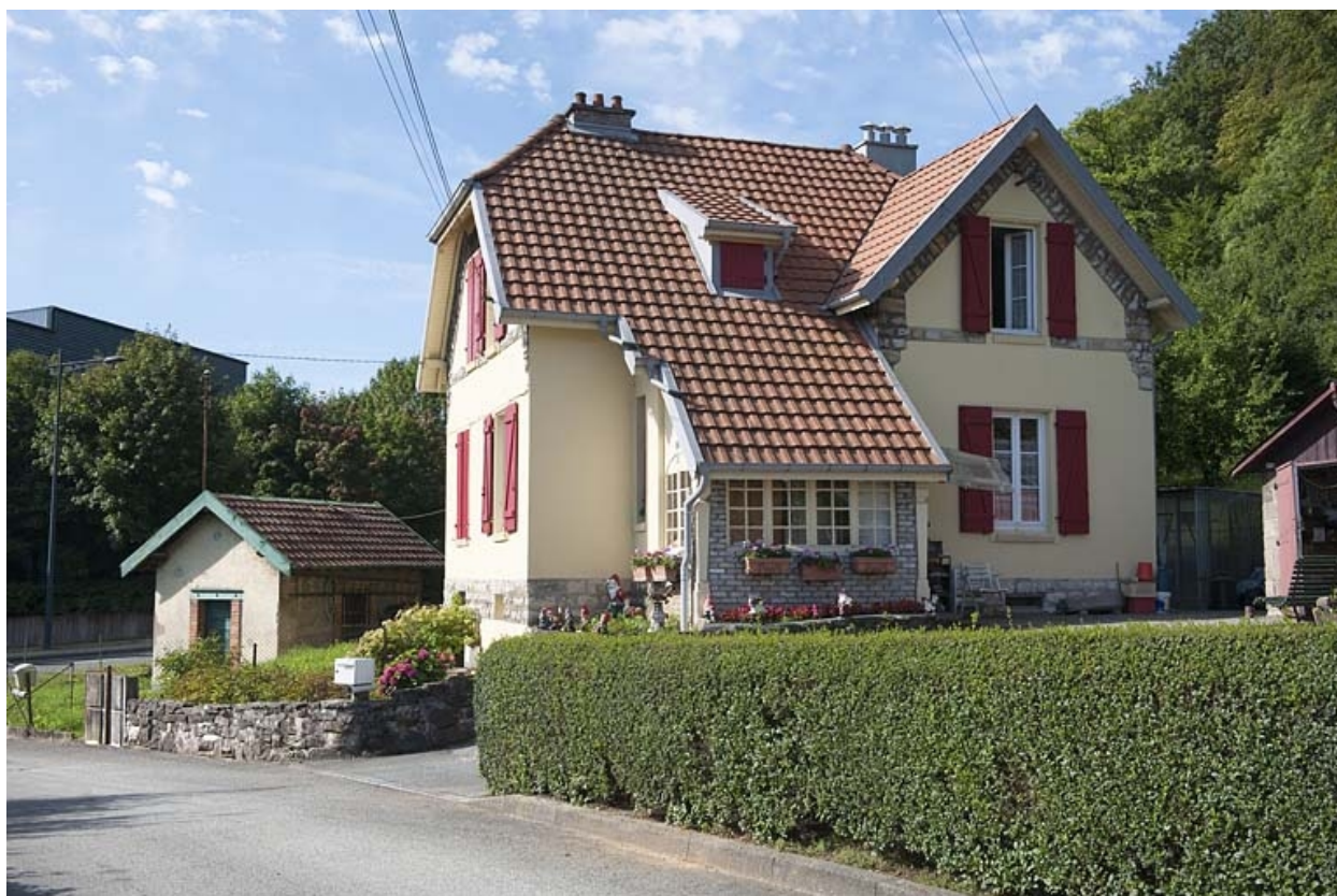
Maison jumelée. Façade est.
